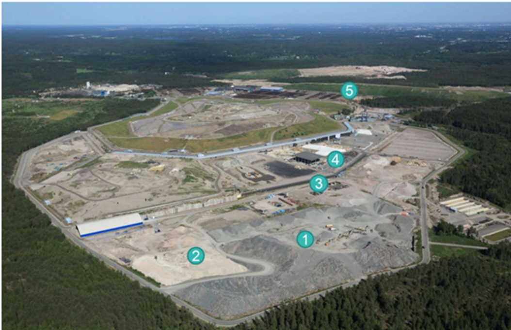
Kuva 16. Ekomon alueelle vuonna 2018 sijoittuneet yritykset ja niiden toiminnot: 1. NCC kiviaineksen jalostus 2. Delete purkubetonin käsittely, 3. Lassila & Tikanoja jätejakeiden siirtokuormaus 4. Tarpaper kattohuopajätteen hyödyntäminen ja 5. Fortum lantapohjaisen polttoaineen jalostus. 141
