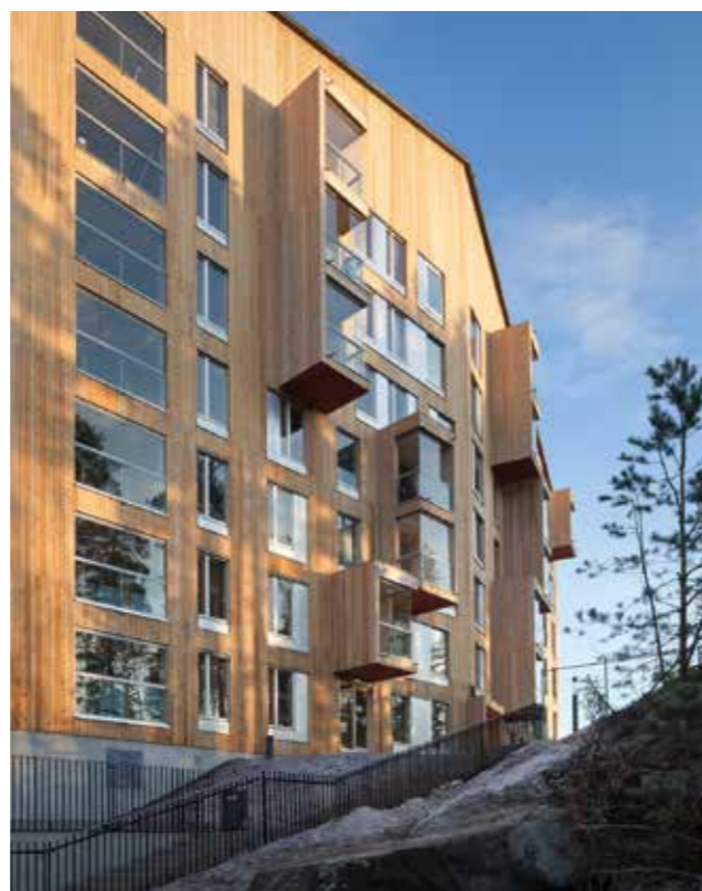
Bild 7. Puukuokka 1, ett höghus av trä med åtta våningar som blev färdigt 2014 i Jyväskylä. (Foto: Lakea Oy)
