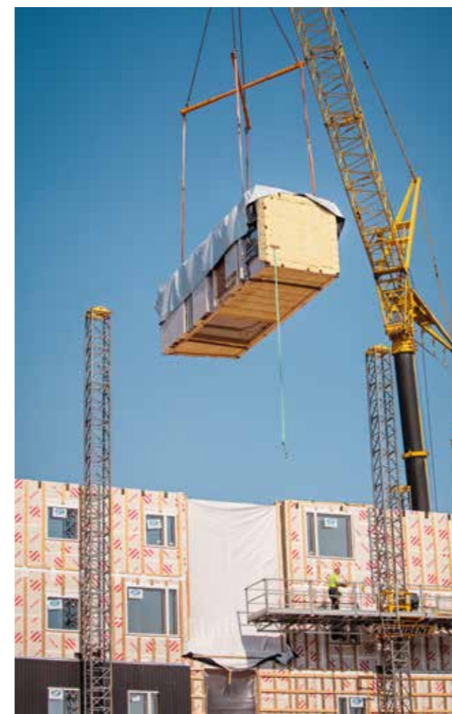
Bild 8. CLT-volymelement i uppförandeskedet
