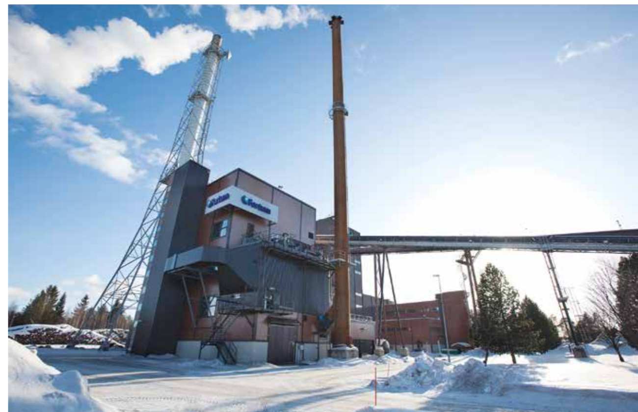
Bild 5. Kraftverket och biooljaaffinaderiet i Joensuu. (Foto: Fortum).
