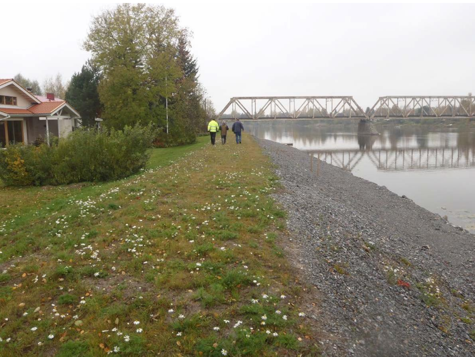
Porin korjattua tulvapengertä, 2010 (Milla Torkkel)
