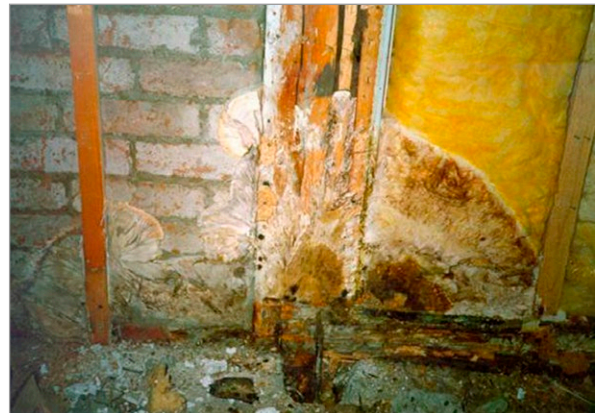
Kuva 6.3. Lattiasieni ( Serpula lacrymans ) a) ennen ja b) jälkeen rakenteen avaamisen. Kuvat: H. Viitanen, VTT.
