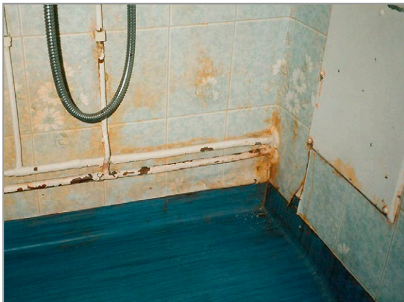
Kuva 7.37. Vasen kuva: Märkätilan vedeneristysnä toimivan muovitapetin sauma on auennut oikeassa alanurkassa. Oikea kuva: Suihku-nurkkauksen alaosassa olevat vuotavat vesijohdotputkien läpiviennit. Kuvat: P. Laamanen, Vahanan Oy.
