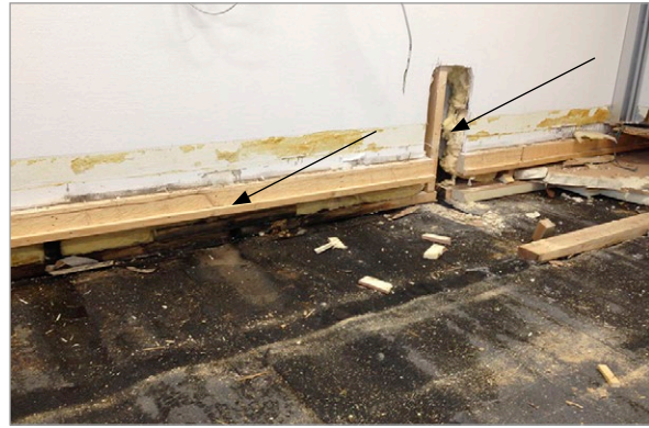
Kuva 3.5. Vasemman puoleisessa kuvassa näkyy putkivuotoepäilyn takia seinä-lattialiittymään tehty rakenneavaus, josta tarkasteltuna rakenteesta todettiin vain hyvin lieviä kosteusjälkiä. Oikean puoleisessa kuvassa näkyy sama kohta lattiarakenne purettuna. Noin metrin päässä aiemmasta rakenneavauksesta seinän alaohjauspuu on täysin laho. Vaurio on kehittynyt tiettyyn kohtaan alapohjarakenteen epätasaisuuden aiheuttaman vuotoveden lammikoitumisen takia. Kuvat: A. Hynninen, Vahanen Oy.
