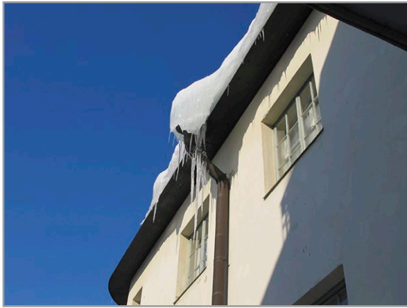
Kuva 7.62. Katon lämpövuodon lumesta sulattaman veden jäätyminen räystäälle. Oikean puoleisessa kuvassa näkyy myös kattovuodon aiheuttamia kosteusjälkiä tiilijulkisivun yläosassa. Kuvat: J. Sievola ja H. Tuovinen, Vahanen Oy.
