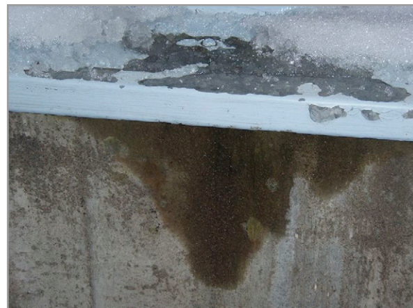
Kuva 7.52. Ikkunapellityksen ja karmin alaosan välissä on selvä rako, joka aiheuttaa alapuolisen rakenteen kosteusvaurioriskin. Kuvat: E. Kauriinvaha, Vahanen Oy.
