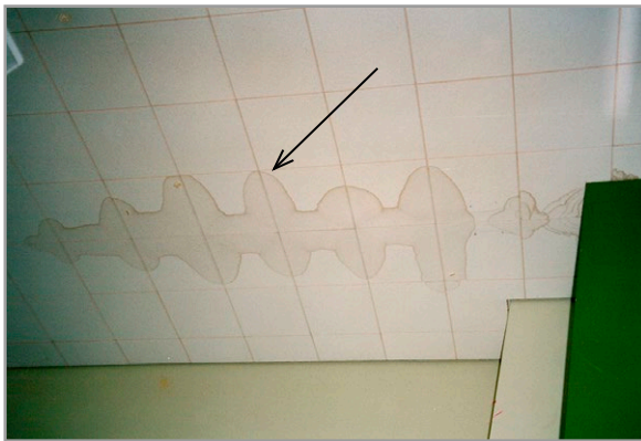
Kuva 7.65. Vasen kuva: valumajälkiä luokkahuoneen katossa. Vauriot olivat syntyneet vesikaton korjauksen yhteydessä. Huom. Kosteuden aiheuttamia jälkiä ei pidä sekoittaa ilmavuotojen aiheuttamiin tummentumiin (oikeanpuoleinen kuva, jälki katon akustointilevyssä ontelolaatan sauman kohdalla). Kuvat: P. Laamanen ja M. Pitkäranta, Vahanen Oy.
