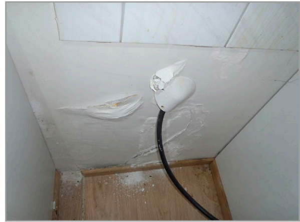
Kuva 7.35. Märkätilaa rajoittavan seinän toisella puolella oleva taustastaan vaurioitunut seinäpinta. Märkätilan puutteellinen vedeneristys on aiheuttanut kosteusvaurion. Kuva: A. Puhka, Indoor Quality Service Oy.
