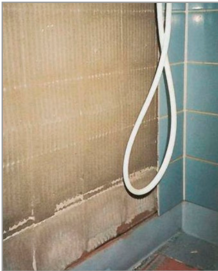
Kuva 7.38. Puretun laatoituksen takaiset ilmaontelot ja seinälle nostetun muovimaton epätiivis sauma. Kuva: V. Pekkala, Vahanen Oy.
