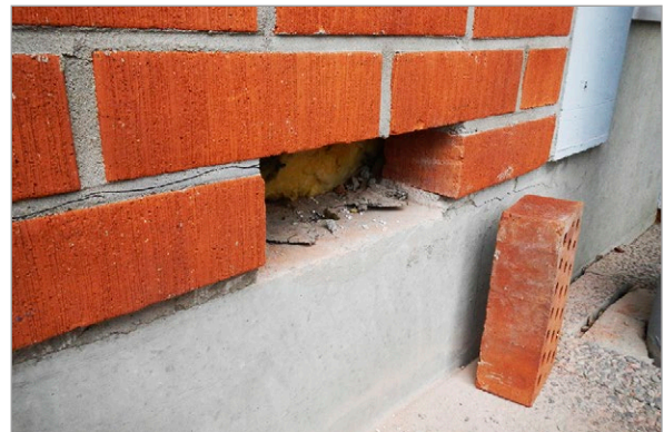
Kuva 3.4. Vasemmalla on bitumikermikatolle tehty rakenneavaus yläpohjarakenteiden tarkastelemiseksi. Rakenneavaus paikattiin välittömästi tutkimusten jälkeen. Oikeanpuoleisessa kuvassa on irrotettu julkisivun tiilimuurauksesta tiili ulkoseinärakenteen toimivuuden tarkastamiseksi. Kuvat: K. Laine ja V. Sandström, Vahnen Oy.
