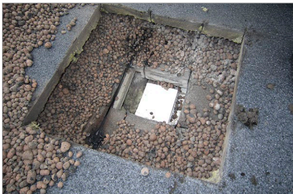
Kuva 3.4. Vasemmalla on bitumikermikatolle tehty rakenneavaus yläpohjarakenteiden tarkastelemiseksi. Rakenneavaus paikattiin välittömästi tutkimusten jälkeen. Oikeanpuoleisessa kuvassa on irrotettu julkisivun tiilimuurauksesta tiili ulkoseinärakenteen toimivuuden tarkastamiseksi. Kuvat: K. Laine ja V. Sandström, Vahnen Oy.
