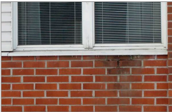
Kuva 7.51. Virheellisesti rakennukseen päin kallistettu ikkunapelti ja esimerkitapauksen vaurioitumisperiaate. Valokuva: M. Pitkäranta, Vahanen Oy.
