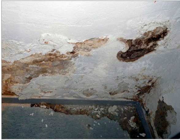
Kuva 6.8. Kivirakenteiseenkin seinään voi kehittyä mikrobivaurio kun aikaa ja kosteutta on riittävästi. Kuvissa ulkopuolisen vedeneristyksen pettäminen on aiheuttanut kosteus- ja mikrobivaurioita maanvastaisen betoniseinän tasoite-, maali- ja tapettikerroksiin. Kuvat: M. Pitkäranta, Vahanan Oy.
