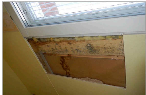
Kuva 3.1. Rakenneavaukset valitaan havaittujen tai oletettujen riskien perusteella. Vasemman puoleisessa kuvassa näkyy julkisivun tiiliverhoukseen ikkunan alapuolelle kehittynyt kosteusvaurio. Oikean puoleisessa kuvassa näkyy sama kohta sisäpuolella rakenneavauksesta tarkasteltuna. Kuvat: M. Pitkäranta, Vahanen Oy.
