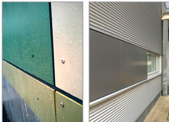
Kuva 7.20. Kuitusementti- ja peltilevyillä toteutetut julkisivut. Kuvat: K. Viljanen, Vahanen Oy.
