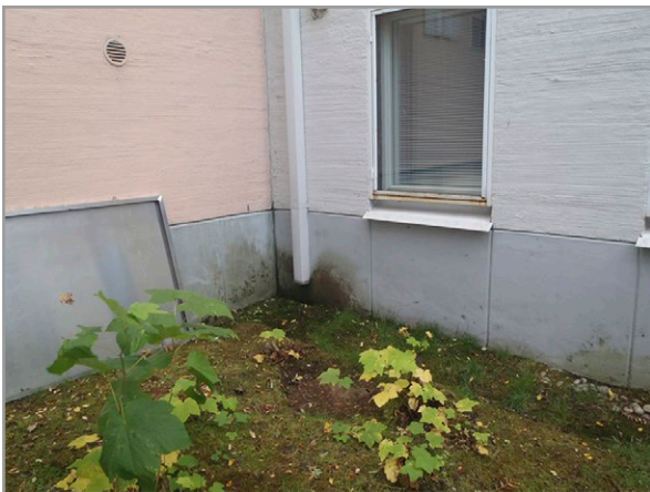
Kuva 7.57. Vasen kuva: Rakennusratkaisu, jossa syöksytorvesta valuva vesi ei mene sadevesikaivoon, vaan kastelee ulkoseinää. Sadevedet imeytyvät maahan perusmuurin vieressä. Oikea kuva: Julkisivun tiiliverhousta vasten asennettu pihakiveyksen asennushiekka on johtanut kosteuden seinärakenteeseen. Kuvat: T. Lammi ja M. Pitkäranta, Vahanen Oy.
