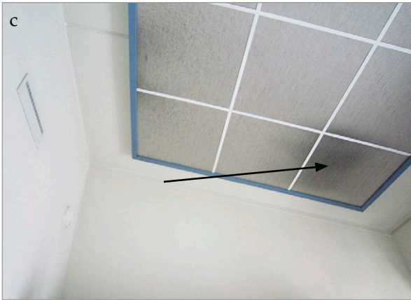
Kuva 6.15. a) vuotoveden aiheuttamaa värjäytymää alakattolevyssä, b) kalkkihärmettä putkitunnelin lattialla c) tuloilmasuihkun aiheuttamaa likaantumista katon akustointimateriaalissa ja d) lämpöpatterin aiheuttaman ilmavirtauksen aiheuttamaa likaantumista seinäpinnassa. Kuvat: M. Pitkäranta ja M. Koskivuori, Vahanen Oy.
