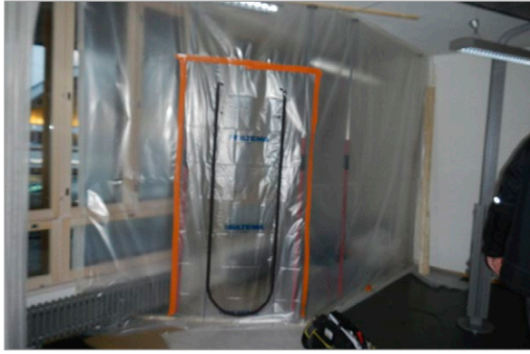
Kuva 3.3. Esimerkkejä huoneen osan osastoinnista ja alipaineistuksesta rakenneavauksia ja korjauksia varten. Osastoinnin sisäpuoli on alipaineistettu kanavapuhaltimella ja ikkunan kautta ulos johdetulla, suodattimella varustetulla poistokanavalla. Kuvat: M. Pitkäranta, A. Hynninen, Vahnen Oy.
