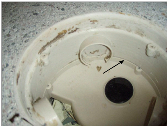
Kuva 7.40. Tiivistämätön korokerengas on yleinen vuotokohta vanhoissa märkätiloissa. Kuvat: P. Puuska, Vahanen Oy.
