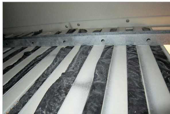
Kuva 3.15. Vasen kuva: huonepölyä elektronimikroskooppilla tarkasteltuna. Oikeanpuoleisessa kuvassa silmännähtävää pölykertymää alakattotilan pinnoilla. Kuvat: J. Sääntti ja M. Pitkäranta, Vahanen Oy.
