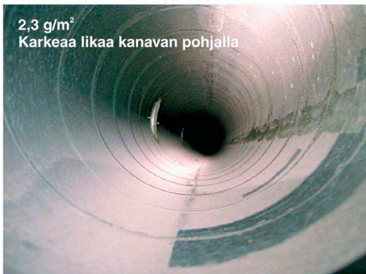
Kuva 3.21. Visuaalinen puhtauden arviointiasteikko kierresaumakanaville, pölykertymä alle 3 g/m 2 . Kuvan lähde: LVI 39-10409. Ilmanvaihtojärjestelmän puhtauden tarkastus. Ilmanvaihdon parannus- ja korjausratkaisut. Lähde: Rakennustietosäätiö RTS ja LVI-Keskusliitto ry, 2007.
