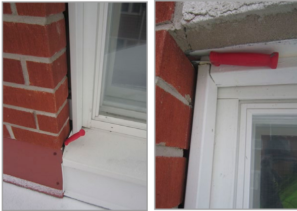
Kuva 7.53. Ikkunan ja julkisivun liitoksesta puuttuu joustava saumaus. Kuvat: K. Laine, Vahanan Oy.
