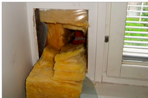
Kuvat 3.2. Rakenneavauksista kannattaa tehdä riittävän isoja, jotta niistä voidaan tehdä mahdollisimman luotettavia tarkasteluja. Vasemmassa kuvassa ikkunalaudan irrottamisen jälkeen havaittiin rakenteiden liitoskohdissa merkittäviä ilmapuotokohtia. Oikealla kuvassa on ulkoseinän sisäkuoreen tehty rakenneavaus. Kuvat: K. Laine ja M. Koskivuori, Vahanan Oy.
