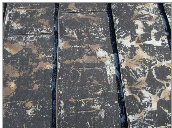
Kuva 7.9. Vanha palapeltikatto, jonka vesitiiveydessä havaittiin puutteita. Kuvat: J. Sievola, Vahanen Oy.
