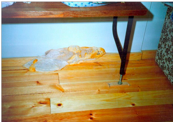
Kuva 6.3. Lattiasieni ( Serpula lacrymans ) a) ennen ja b) jälkeen rakenteen avaamisen. Kuvat: H. Viitanen, VTT.
