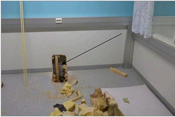
Kuva 3.5. Vasemman puoleisessa kuvassa näkyy putkivuotoepäilyn takia seinä-lattialiittymään tehty rakenneavaus, josta tarkasteltuna rakenteesta todettiin vain hyvin lieviä kosteusjälkiä. Oikean puoleisessa kuvassa näkyy sama kohta lattiarakenne purettuna. Noin metrin päässä aiemmasta rakenneavauksesta seinän alaohjauspuu on täysin laho. Vaurio on kehittynyt tiettyyn kohtaan alapohjarakenteen epätasaisuuden aiheuttaman vuotoveden lammikoitumisen takia. Kuvat: A. Hynninen, Vahanen Oy.
