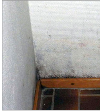
Kuva 6.8. Kivirakenteiseenkin seinään voi kehittyä mikrobivaurio kun aikaa ja kosteutta on riittävästi. Kuvissa ulkopuolisen vedeneristyksen pettäminen on aiheuttanut kosteus- ja mikrobivaurioita maanvastaisen betoniseinän tasoite-, maali- ja tapettikerroksiin. Kuvat: M. Pitkäranta, Vahanan Oy.
