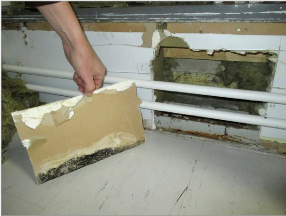
Kuva 6.12. Mikrobikasvu esiintyy usein kerroksellisen rakenteen sisällä heikosti kuivuvassa kohdassa. Kuvat: J. Sievola ja M. Pitkäranta, Vahanan Oy.
