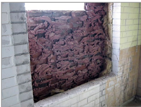
Kuva 7.55. Saumapurseiden tukkimasta tuuletusväli. Kuva: E. Salo, Vahanan Oy.
