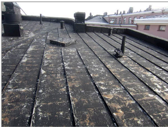
Kuva 7.9. Vanha palapeltikatto, jonka vesitiiveydessä havaittiin puutteita. Kuvat: J. Sievola, Vahanen Oy.
