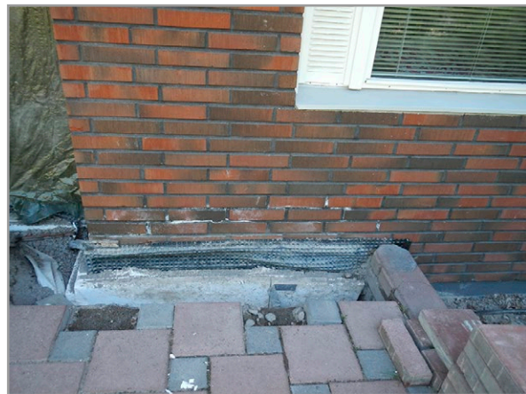
Kuva 7.57. Vasen kuva: Rakennusratkaisu, jossa syöksytorvesta valuva vesi ei mene sadevesikaivoon, vaan kastelee ulkoseinää. Sadevedet imeytyvät maahan perusmuurin vieressä. Oikea kuva: Julkisivun tiiliverhousta vasten asennettu pihakiveyksen asennushiekka on johtanut kosteuden seinärakenteeseen. Kuvat: T. Lammi ja M. Pitkäranta, Vahanen Oy.
