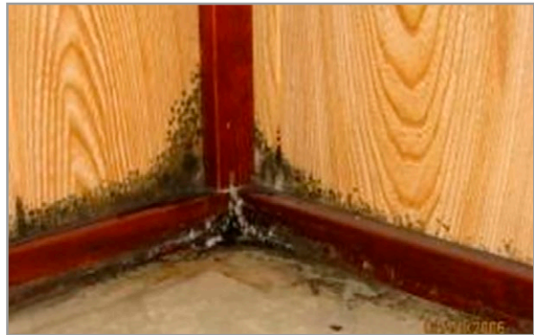
Kuva 7.33. Taustarakenteen kapillaarisen kosteuden vaurioittama jalkalista ja esimerkkitapauksen vaurioitumisperiaate. Valokuva: Vahanen Oy.
