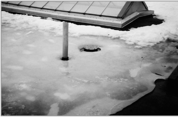
Kuva 7.64. Lämpimän läpiviennin aiheuttama veden patoutuminen katolle ja esimerkitapauksen vaurioitumisperiaate. Valokuva: P. Laamanen, Vahanen Oy.
