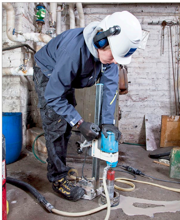
Kuva 3.18. Materiaalinäytteenotto öljyhiilivetykontaminoituneeksi epäillystä alapohjarakenteesta timanttipurauksella. Kuva: Vahanan Oy.
