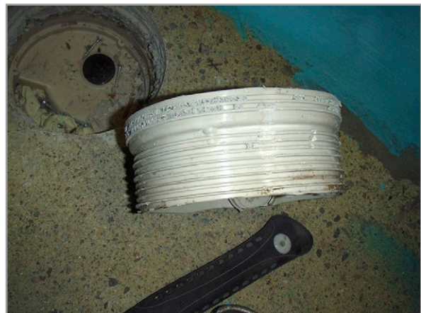
Kuva 7.40. Tiivistämätön korokerengas on yleinen vuotokohta vanhoissa märkätiloissa. Kuvat: P. Puuska, Vahanen Oy.
