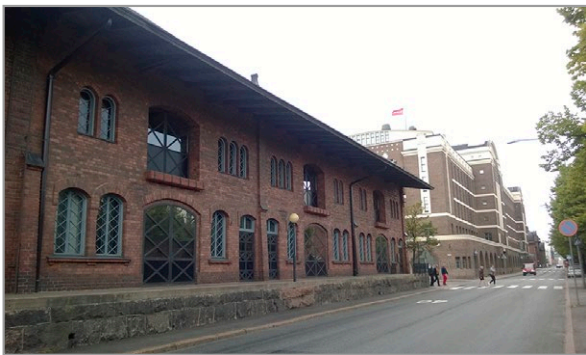
Kuva 7.13. Esimerkki pitkästä räystäästä, joka vähentää seinään kohdistuvaa saderasitusta merkittävästi. Kuva: K. Viljanen, Vahanen Oy.
