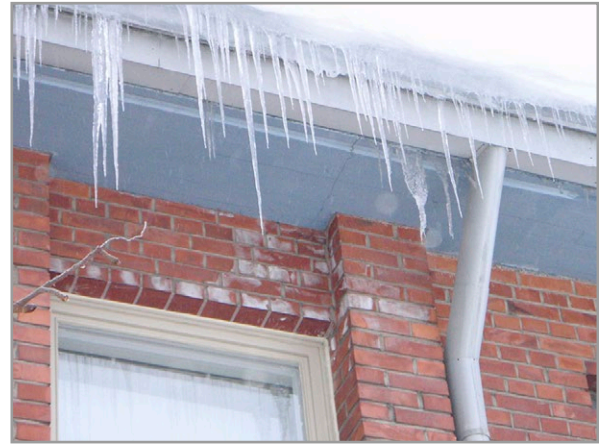
Kuva 7.62. Katon lämpövuodon lumesta sulattaman veden jäätyminen räystäälle. Oikean puoleisessa kuvassa näkyy myös kattovuodon aiheuttamia kosteusjälkiä tiilijulkisivun yläosassa. Kuvat: J. Sievola ja H. Tuovinen, Vahanen Oy.
