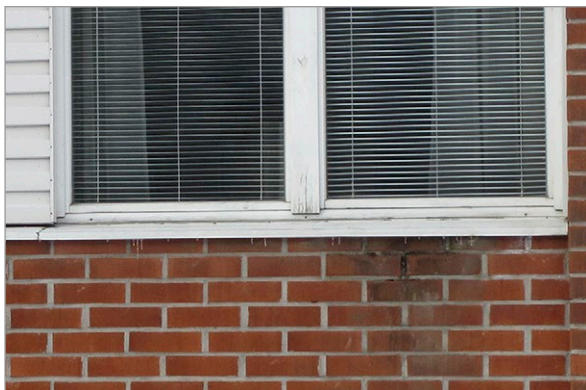
Kuva 3.1. Rakenneavaukset valitaan havaittujen tai oletettujen riskien perusteella. Vasemman puoleisessa kuvassa näkyy julkisivun tiiliverhoukseen ikkunan alapuolelle kehittynyt kosteusvaurio. Oikean puoleisessa kuvassa näkyy sama kohta sisäpuolella rakenneavauksesta tarkasteltuna. Kuvat: M. Pitkäranta, Vahanen Oy.
