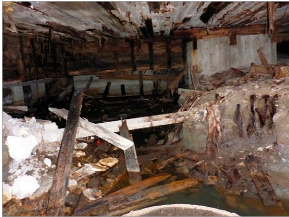
Kuva 6.14. Lahovaurioita a) yläpohjassa vesikaton ruodelaudoituksessa, b) puutteellisesti pellitettyssä ja -maalatussa ikkunan karmi-rakenteessa, c) betonirakenteisen ryömintätilan muottilaudoituksessa ja d) puutteellisesti vedeneristetyssä märkätilan kynnyksessä. Kuvat: E. Kauriinvaha, E. Salo, Vahanen Oy.
