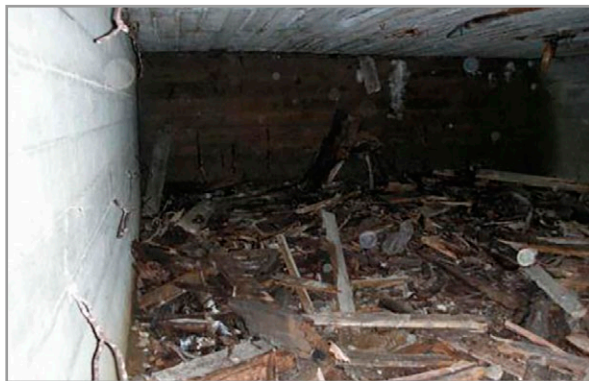
Kuva 7.100. Ryömintätila, johon on jätetty purettu muottilauditus. Kuva: P. Räisänen, Vahanen Oy.
