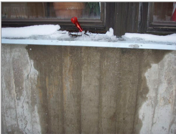
Kuva 7.52. Ikkunapellityksen ja karmin alaosan välissä on selvä rako, joka aiheuttaa alapuolisen rakenteen kosteusvaurioriskin. Kuvat: E. Kauriinvaha, Vahanen Oy.
