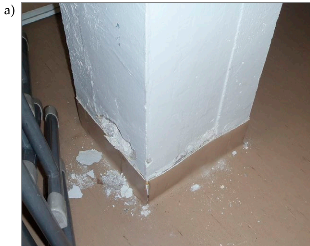
Kuva 7.31. Kapillaarisen veden imeytymisen aiheuttama pinnoitteen irtoaminen ja esimerkitapauksen vaurioitumisperiaate. Kuvissa b ja c on esitetty rakennepaksuuden vaikutus kapillaariseen nousukorkeuteen. Valokuva: T. Lammi, Vahanen Oy.
