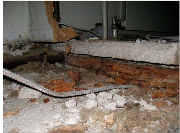
Kuva 6.14. Lahovaurioita a) yläpohjassa vesikaton ruodelaudoituksessa, b) puutteellisesti pellitettyssä ja -maalatussa ikkunan karmi-rakenteessa, c) betonirakenteisen ryömintätilan muottilaudoituksessa ja d) puutteellisesti vedeneristetyssä märkätilan kynnyksessä. Kuvat: E. Kauriinvaha, E. Salo, Vahanen Oy.
