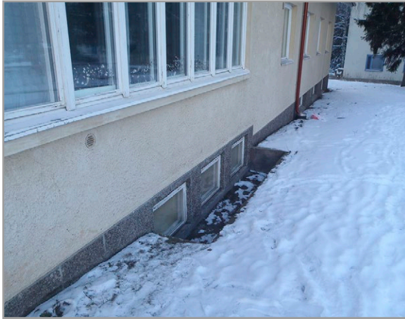
Kuva 7.80. Ikkunoiden alareuna on pihan maanpinnan alapuolella, ja ympäröivä maa viettää rakennukseen päin. Ratkaisu aiheuttaa kosteusvaurioriskin. Kuva: T. Lammi, Vahanen Oy
