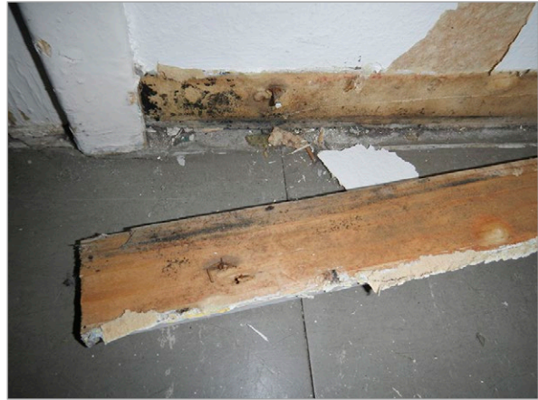
Kuva 6.12. Mikrobikasvu esiintyy usein kerroksellisen rakenteen sisällä heikosti kuivuvassa kohdassa. Kuvat: J. Sievola ja M. Pitkäranta, Vahanan Oy.
