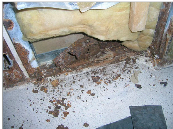
Kuva 7.34. Vasen kuva: Märkätilan väliseinä vastakkaiselta puolelta avattuna. Seinän kipsilevyn kartonkipinta on alkanut homehtumaan. Oikea kuva: Puretun märkätilan seinän alaosan rakenteet ovat vaurioituneet puutteellisesta vedeneristyksestä johtuen. Lattiaa vasten oleva teräsranka on ruostunut puhki. Kuvat P. Puuska, Vahanen Oy.
