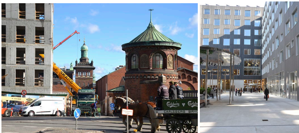
Kuvat 10 ja 11. Uudet asunnot rakentuvat Carlsberg Byenissä limittäin vanhan panimomiljöön kanssa (10). Aseman vieressä sijaitsevalla aukiolla toimii ammattikorkeakoulu, kauppoja ja kahviloita (11).
