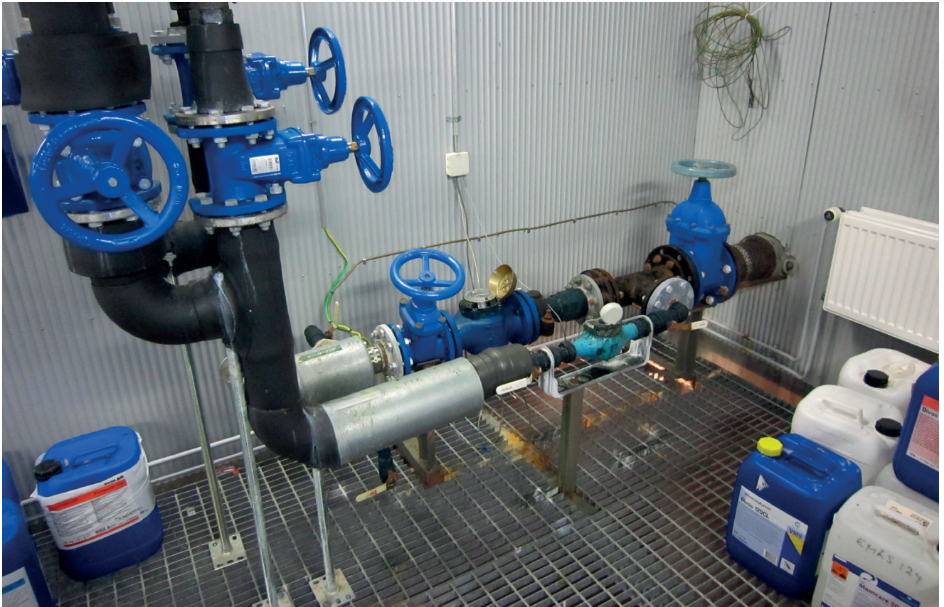
Tuotantolaitoksen vesiliittymä. Lähde: Valio Oy, Seppo Morander
