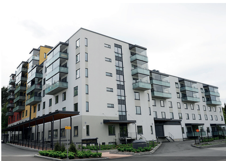
Kuva 14. Onnelanpolun palvelutalon julkisivu.
