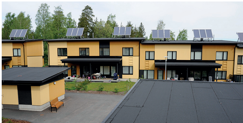
Kuva 26. Jokaisella asunnolla on käytössä omat aurinkolämpökeräimet, joita hyödynnetään lämpimän käyttöveden valmistuksessa.
