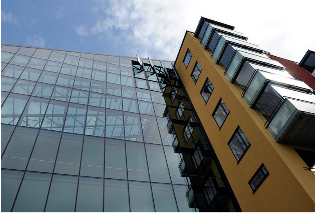
Kuva 15. Atrium toimii Onnelanpolun palvelutalon lämpöakkuna.
