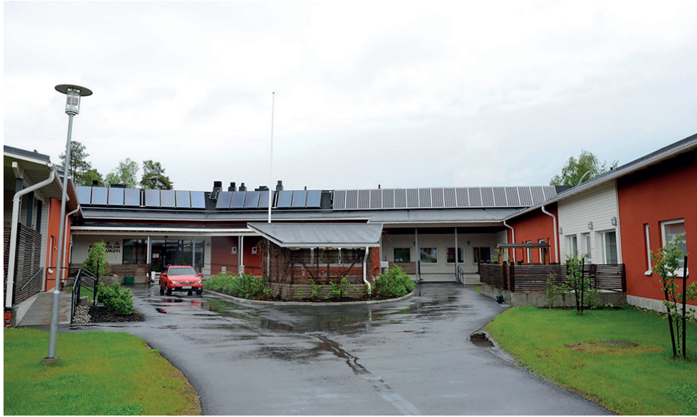
Kuva 30. Aurinkolämpökeräimet ja aurinkosähköpaneelit on suunnattu etelää kohti.
