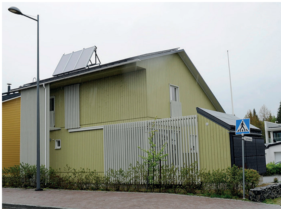
Kuva 21. Lantti-talossa aurinkoenergiaa tuotetaan päärakennukseen sekä ulkovaolinevarastoon integroiduilla paneeleilla ja keräimillä. Ikkunoiden eteen asennetut säleiköt suojaavat suoralta auringonsäteilyltä ja vähentävät näin jäähdytystarvetta.
