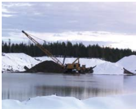
Kuva 3. Soran ottamista pohjavesipinnan alapuolelta.
