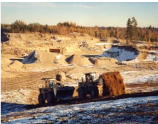
Kuva 28. Pintamateriaalin levittäminen ottamisalueelle parantaa kasvillisuuden kasvuolosuhteita ja edistää pohjaveden suojelua.
