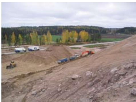
Kuva 15. Ottamisalueen vähimmäisetäisyys maantiele tulisi olla vähintään 50 metriä tien keskilinjasta.
