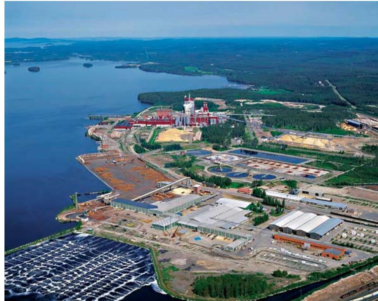
Enocell Oy Uimaharjussa, kuva Enocell Oy.
