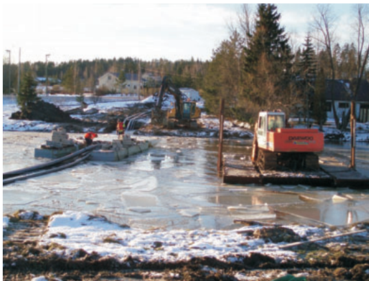
Kuva 6. Pornainen – Kerava siirtovesihuoltolinjan rakentamiseen liittyvä Mustijoen alitus painottamalla Halkiassa (Hanna Yli-Tolppa).
