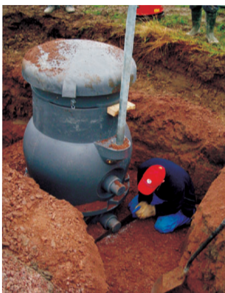
Kuva 12. Etelä-Pornaisten Vesiosuuskunnan kiinteistöpumppaamon asennus (Hanna Yli-Tolppa).
