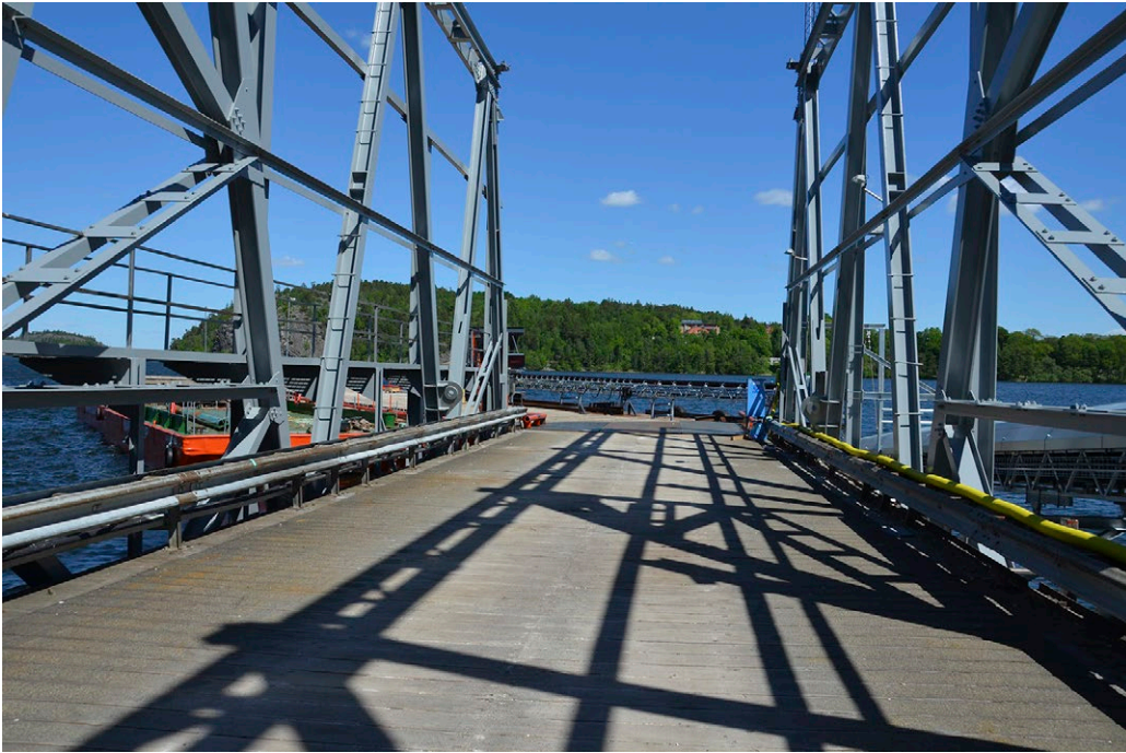
Kuva 13. Slagstan väliaikainen lastaus-, jalostus- ja varastointialue koostuu rannalla sijaitsevasta tuotanto- ja varastointialueesta, johon kuljetetaan hihnakuljettimilla 0/150 mm murskeet proomuista. Lastauslaituri on rakennettu vanhasta ponttonisillasta sekä proomusta. (kuva: Mika Räisänen)
