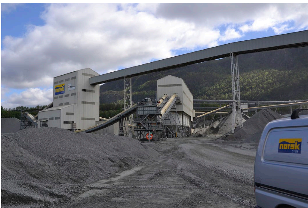
Kuva 18. Metson toteuttama Berakvamin louhoksen murskaus- ja seulontalaitteistojen toimituksen ja palveluiden seurauksena louhoksen kapasiteetti kaksinkertaistui Euroopan suurimmaksi tuotantolaitokseksi. (Kuva: Mika Räisänen)
