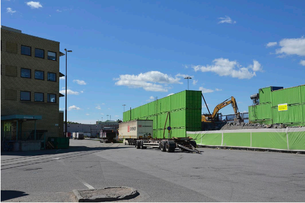
Kuva 1. Årstan rakentamisen tukialue sijaitsee n. 50 metrin etäisyydellä toimistorakennuksista tehokkaiden melu- ja pölypäästöt ehkäisytoimien johdosta. (Kuva: Mika Räisänen)
