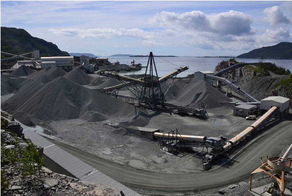
Kuva 9. Kiviainestuotteiden jalostusta, varastointia ja lastausta hihnakuuljettimilla laivoihin Berakvamin louhoksella Jelsassa Norjassa. (kuva: Mika Räisänen)
