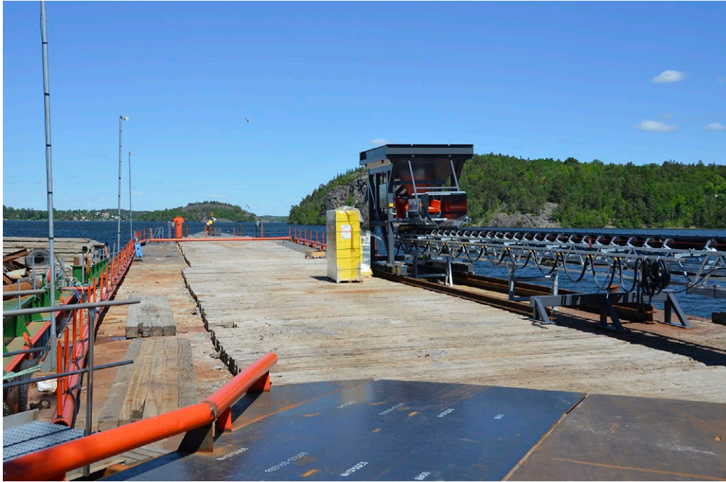
Kuva 5. Väliaikainen proomuun perustuva lastauslaituri Slagstassa n. 20 km lounaaseen Tukholman keskustasta. (kuva: Mika Räisänen)
