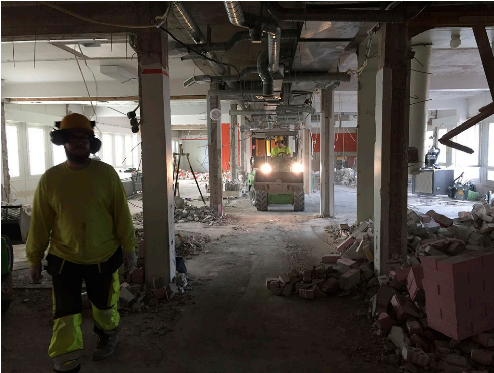
Kuva 6. Päiväkodin purkutyömaa Porissa. Kuva Katja Lehtonen.
