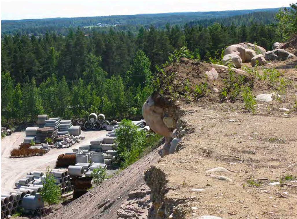
Bild 30. Branta sluttningar kan utgöra en rasrisk i gruståkten.
