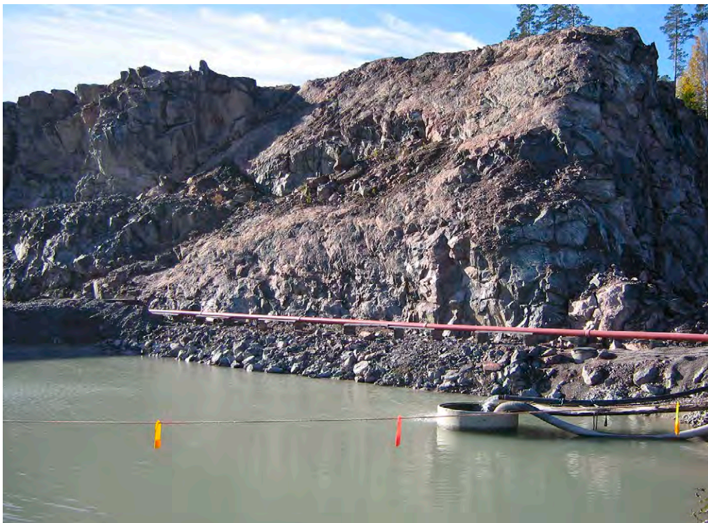
Bild 28. Skadliga ämnen från täkten får inte hamna i omgivningen med ytvatten. Vid behov ska vattnet ledas via en sedimenteringsbassäng innan det leds ut från täktområdet.
