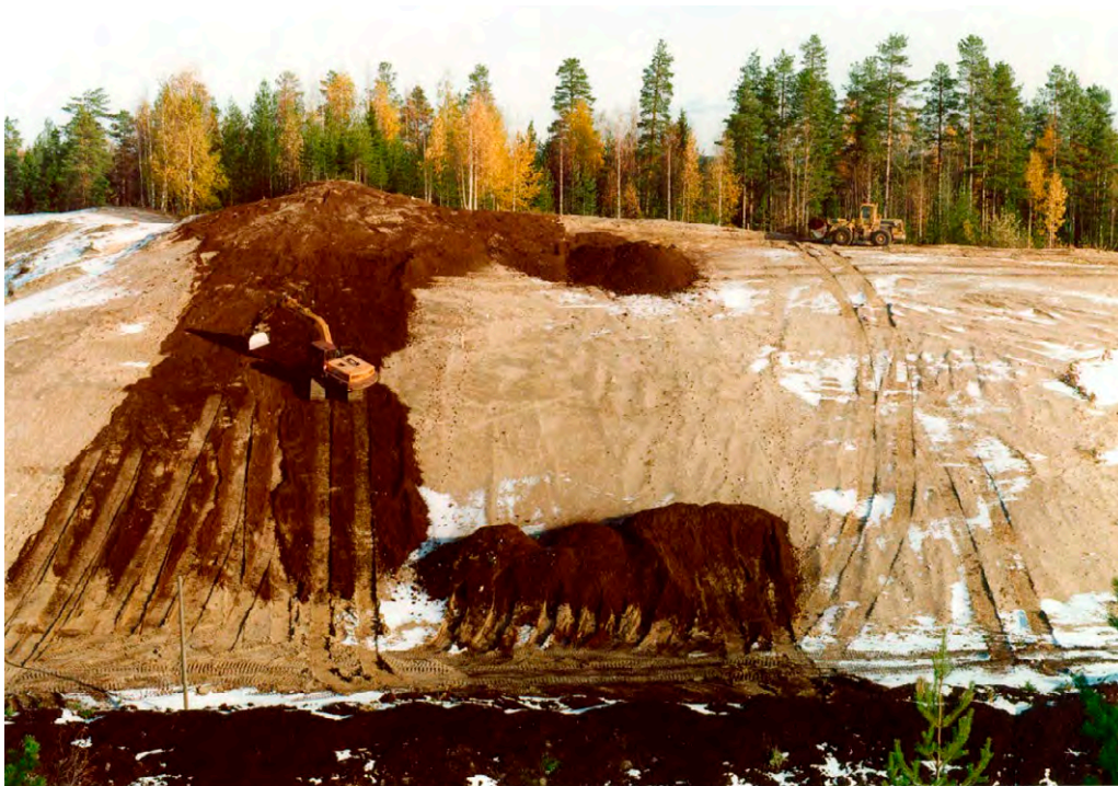
Bild 49. De massor som breds ut vid efterbehandlingen av tälter ska bestå av rent material som inte skadar grundvattnet.
