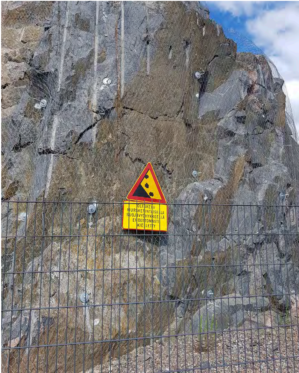
Bild 47. Branta klippväggar som eventuellt lämnas kvar i ett stenbrott ska göras säkra till exempel med skyddskonstruktioner.
