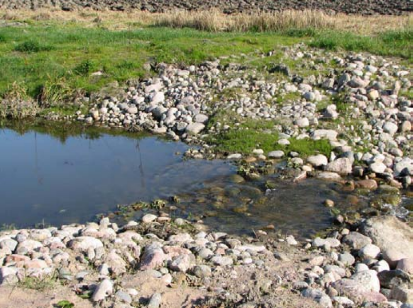
Pohjapadolla voidaan muodostaa uomaan allas ja hidastaa virtausta, jolloin osa kiintoaineesta ehtii laskeutua. Kuva: Anni Karhunen
