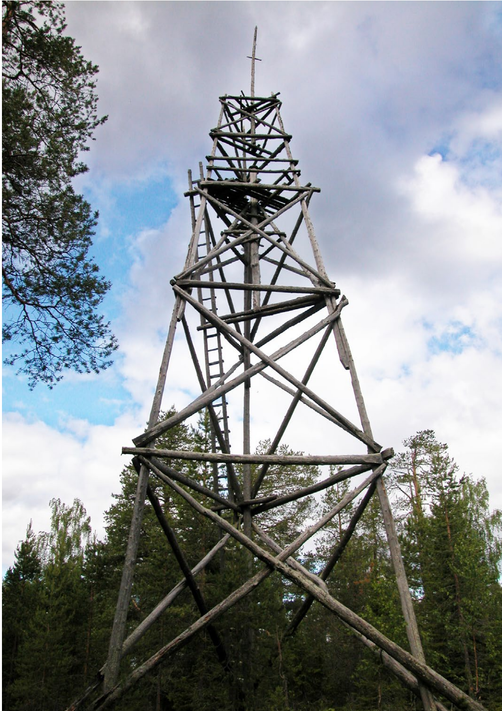
Kuva 11.3. Pitkälle lahonnut kolmiomittaustorni oli vielä vuonna 2003 pystyssä Pellon Niemivaaran (KA0120038) laella. Kuva: Jukka Husa.
