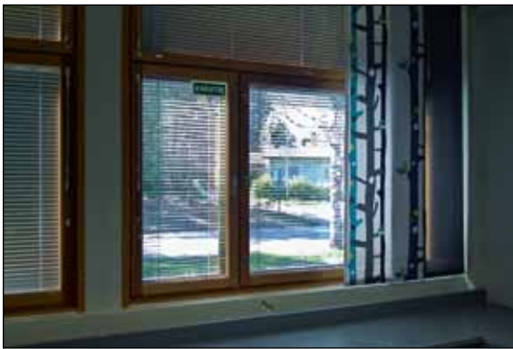
Kuva 9. Pakenemisikkuna, jossa ovat kiintokahva ja varatiemerkinä. On otettava huomioon etteivät pienet lapset pääse omin päin avaamaan ikkunaa. (kuva: Mikko Helasvuo)
