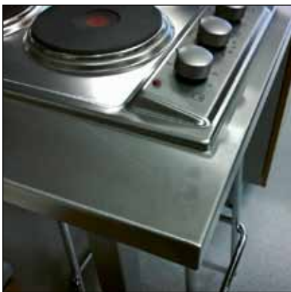
Kuva 10. Suojaamaton terävä työtason kulma opetustilan kulkureitillä (kuva: Mikko Helasvuo)
