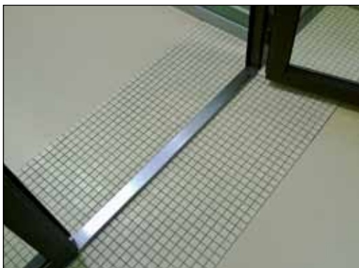
Kuva 17. Osastoivan oven kynnyksen savun leviämisen estämiseksi. Vaihtoehtoinen ratkaisu on laahus oven alareunassa. (Kuva: Mikko Helasvuo)
