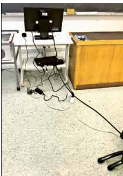
Kuva 12. Väärin sijoitetut jatkojohdot aiheuttavat kompastumisvaaran (kuva: Mikko Helasvuo)
