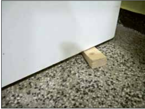
Kuva 15. Varsin yleinen, määräysten vastainen tilanne – palo-ovi on kiilattu auki. (kuva: Mikko Helasvuo)
