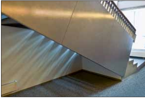
Kuva 6. Kulkureitillä olevan portaan rakenteisiin lyö helposti päänsä. Portaan alapään alin yllätyksellinen askelma aiheuttaa kompastumisvaaran ja ikkuna aiheuttaa häikäistymistä. Käsijohteet eivät jatku riittävän pitkälle. (kuva: Mikko Helasvuo)
