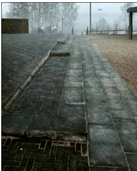
Kuva 1. Kontrastien puute aiheuttaa kompastumis- ja putoamisvaaraa pihaportaita käytettäessä. (kuva: Mikko Helasvuo)
