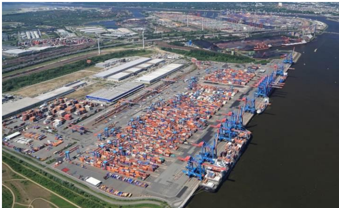
Kuva 27. Hampurin HHLA Altenwerder –konttiterminaali. 56
