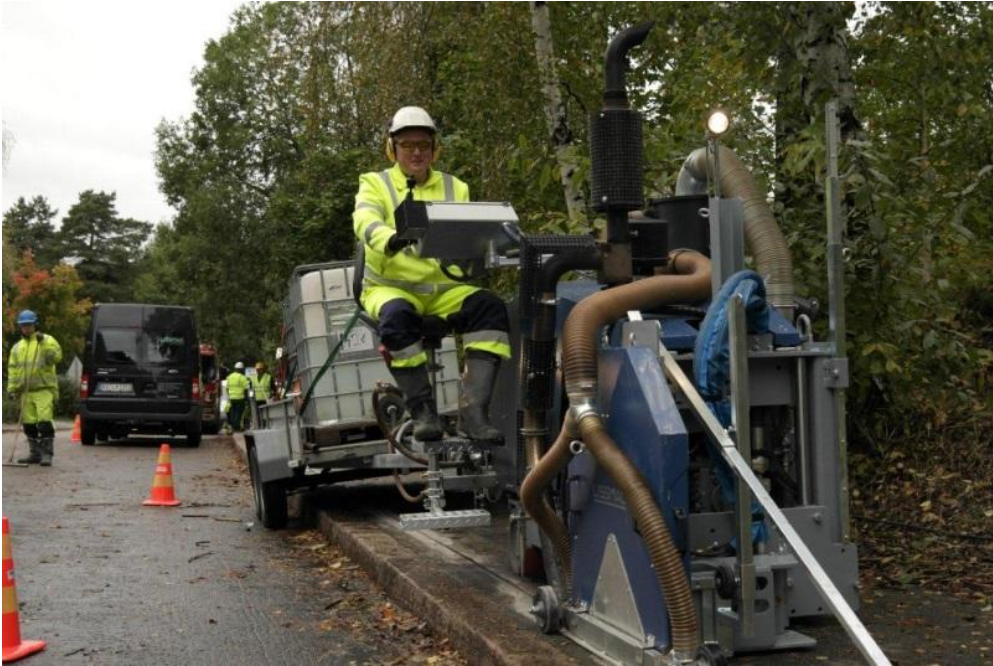
Kuva 13 Holvisahalla tehtävää valokuituverkon rakentamista (Lähteinen)
