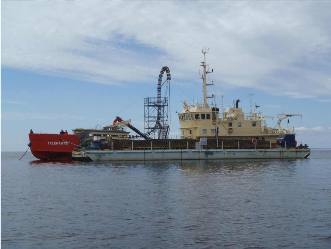
Kuva 17 Vesistökaapelin laskua kaapelialukselta (Lammes)
