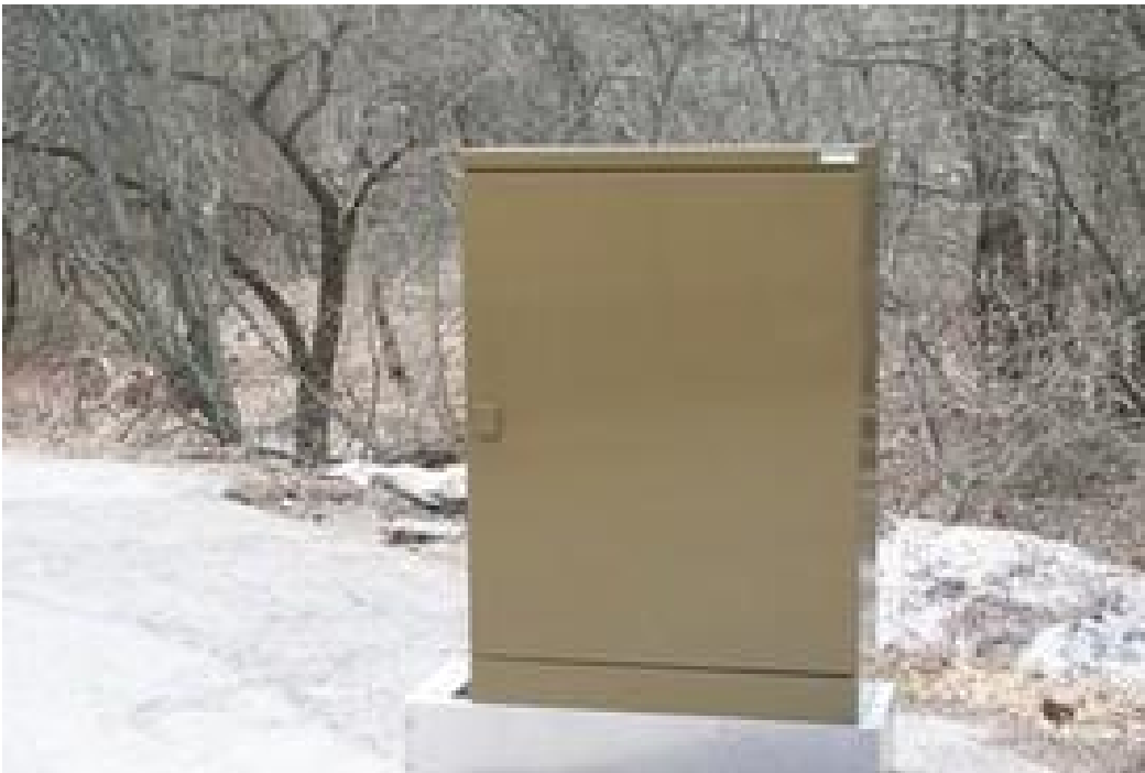
Kuva 10 Ulkojakokaappi (Mecafer Oy)
