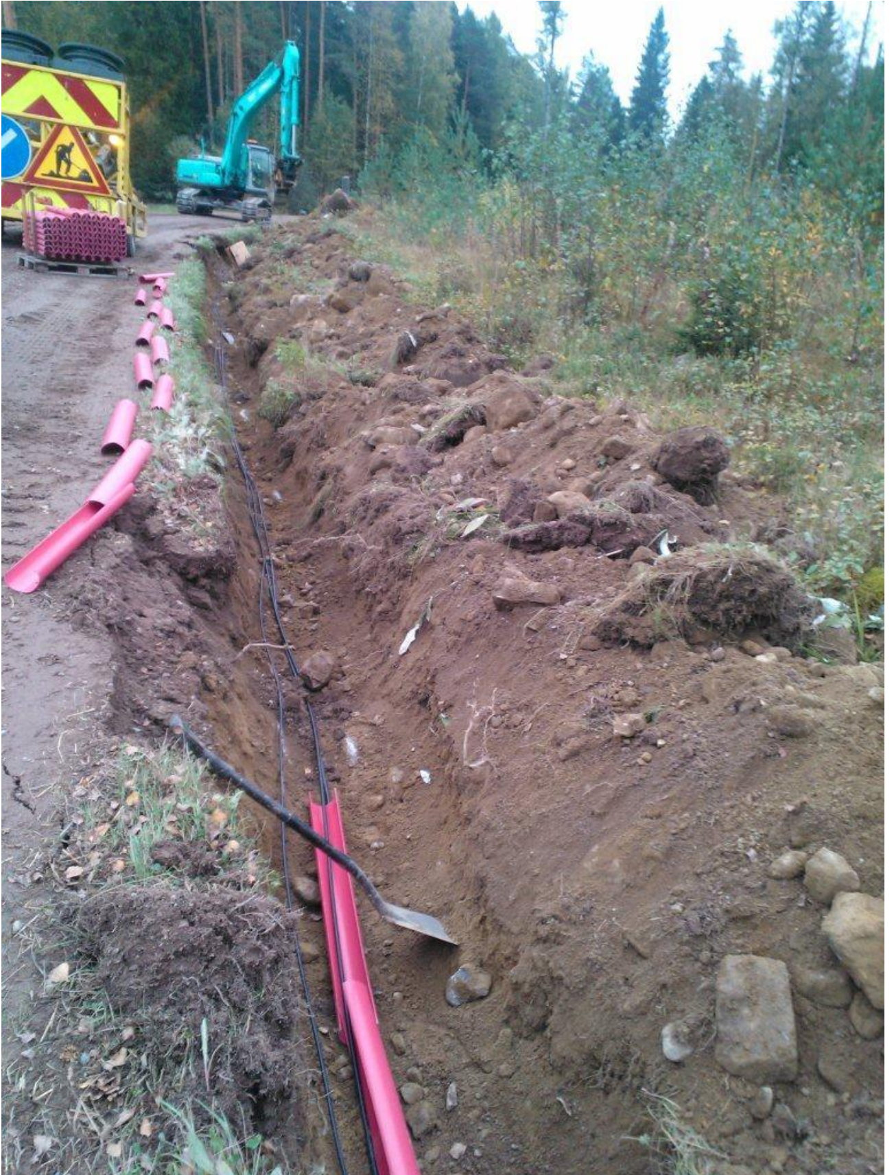
Kuva 12 Valokuituverkon rakentaminen kaivamalla. (Lähteinen)
