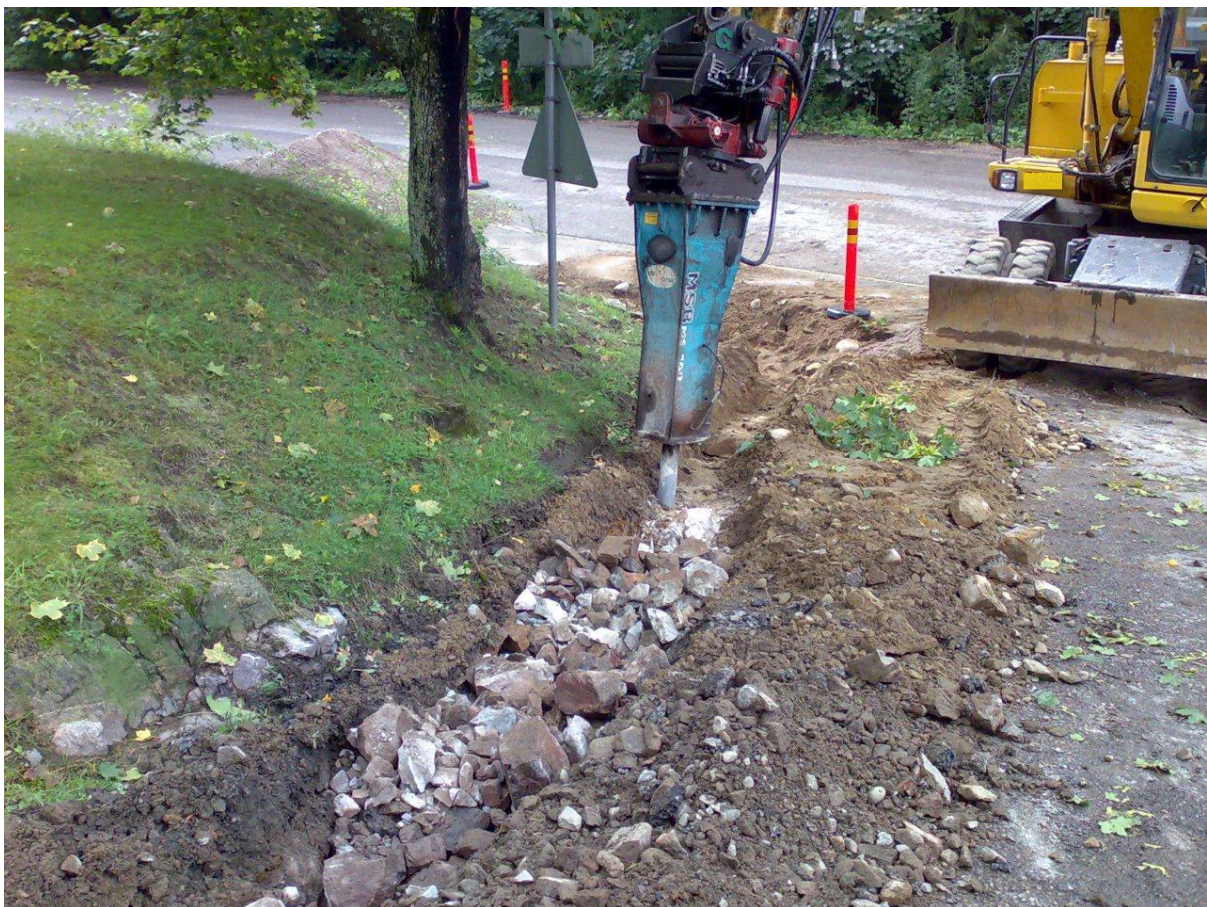
Kuva 15 Kaapelireitin louhintaa iskuvasaralla. (Lähteinen)
