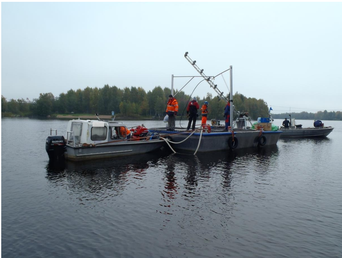
Kuva 16 Vesistökaapelin laskua ponttooneilta (Lammes)
