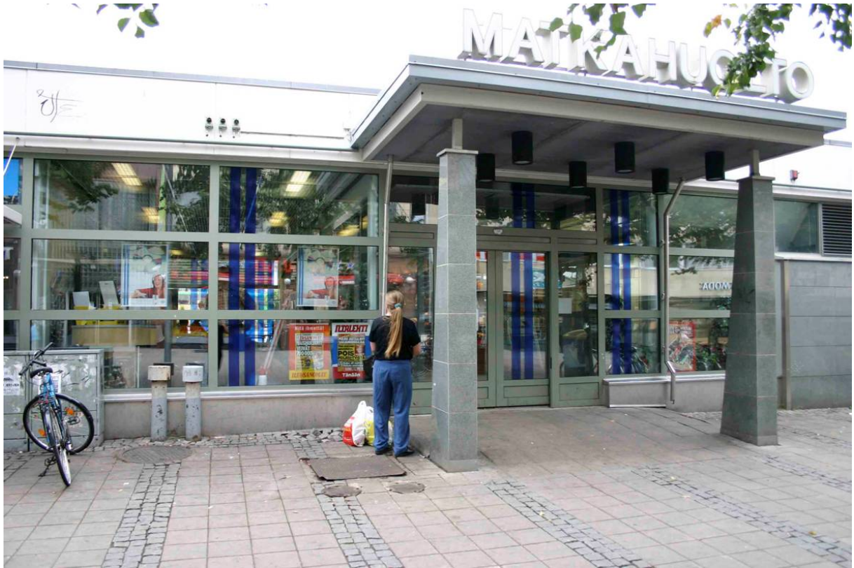
Kuva 16. Porvoon Matkahuolto on tunnistettavissa jo ulkoa siniraitaisesta tunnuksestaan.
