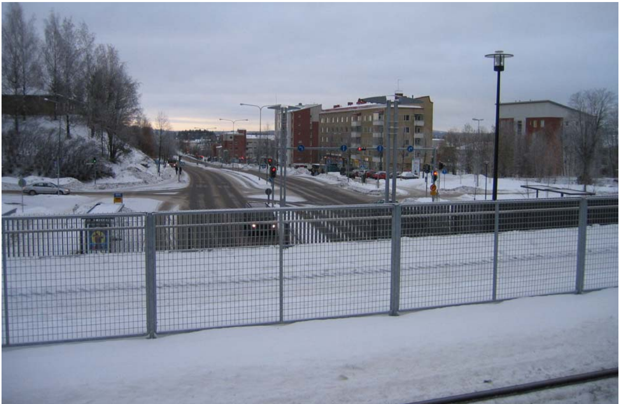
Kuva 34: Tyypillinen rautatieympäristöjen kuumasinkitty teräksen värinen turva-aita soveltuu käytettäväksi teollisuusympäristöissä, mutta ympäristön arkkitehtonisiin vaatimuksiin tällainen aita harvemmin vastaa. Kuva Lahden rautatieaseman läheisyydestä.
