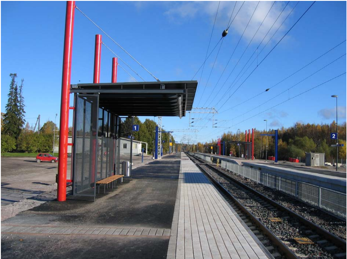
Kuva 30. RHK:n Masalan uusi laiturikatoks suojaa tuulelta ja sateelta pitkällä lipalla ja sivuseinäkkeillä. Pienien puuasemien tyyliin sopivia laiturikatoksia ei tällä hetkellä ole olemassa.
