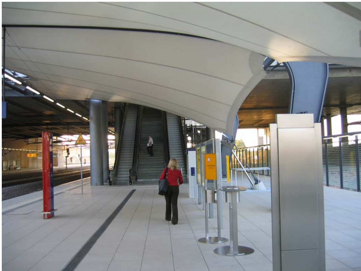
Kuva 47. Kevyt laiturikatos Leipzig / Hallen lentokentällä v. 2003, jossa on käytetty pingoitettua kangasta. Tämä on Münchenin olympialaisista v. 1972 lähtien Saksassa hyvin yleisesti käytetty katostyyppi.
