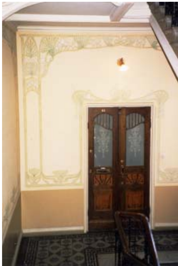
Hissin asentaminen tähän jugend-kauden porrashuoneeseen olisi mahdoton tehtävä mikäli alkuperäiset rakennusosat ja maalaukset halutaan säilyttää. Kuva Anne Mäkinen 2002, HKM.
