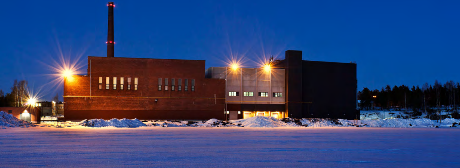
Googlen palvelinkeskus Haminassa on hyvä esimerkki tehasrakennusta kunnioittavasta käyttötarkoituksen muutoksesta ja olemassa olevan tilanteen hyödyntämisestä uudella tavalla. Tehtaan alkuperäinen jäähdytysjärjestelmä on edelleen käytössä. Kuva: Google / Connie Chou
