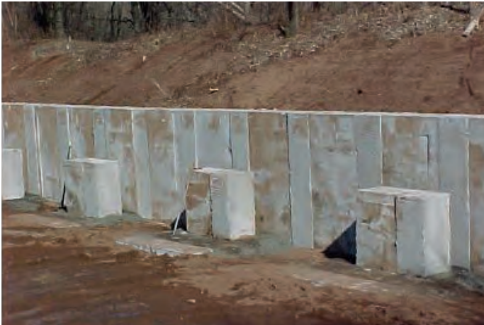
Kuva 5.12. Sacon-luotiloukku rakennusvaiheessa (Terran Corporation 2011).
