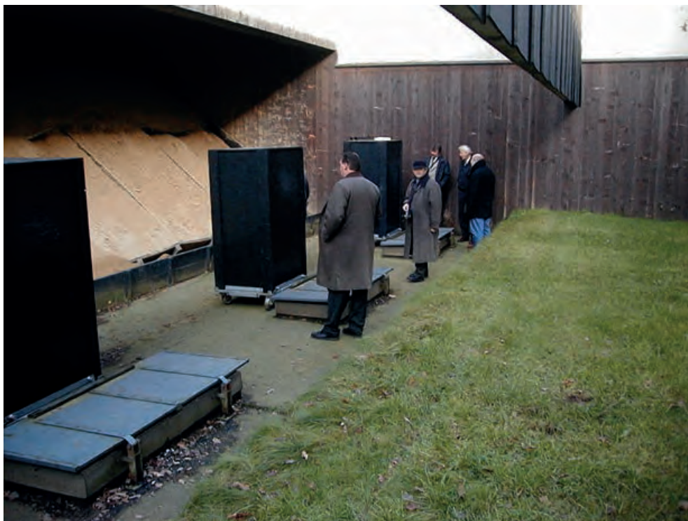
Kuva 5.14. Saksan käyttämä kumirouhelaatikko Coesfeldissä (Nikula ym. 2005).
