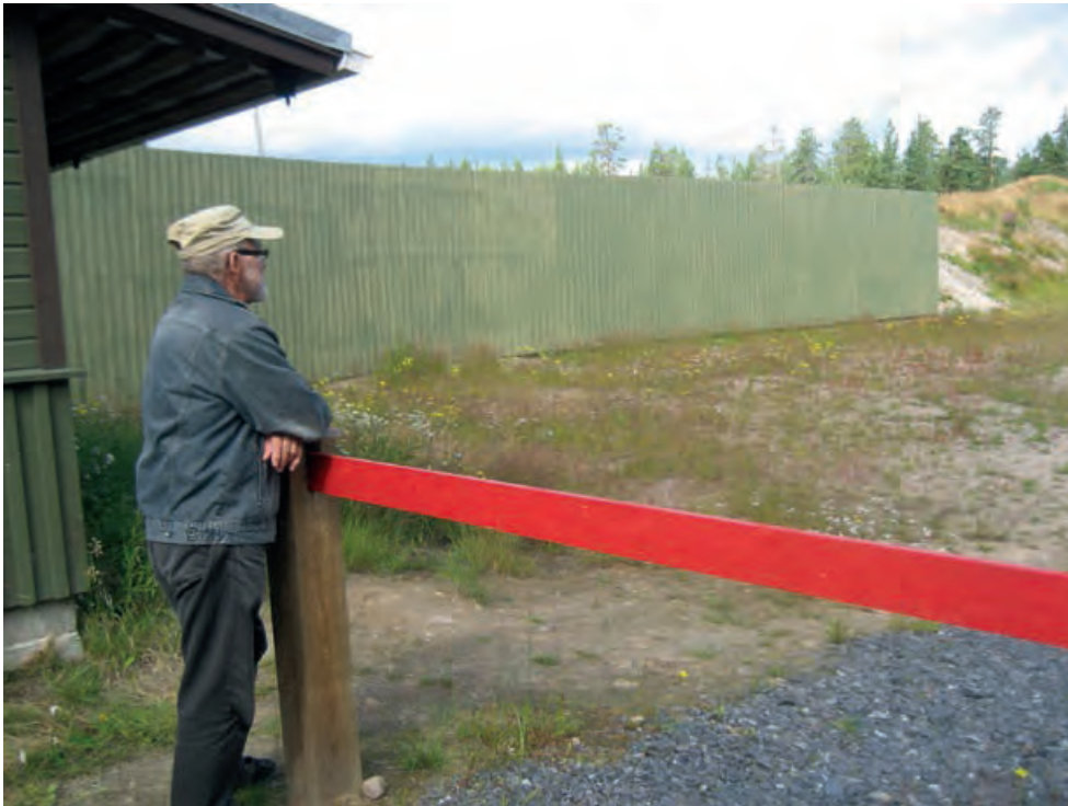
Kuva 9.11. Hirviradalle tehtyä ääntä heijastava meluaita.
