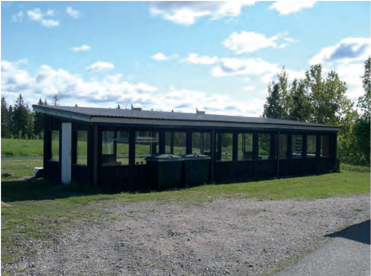
Kuva 9.14. Sipoon SSG:n ampumaradalla trap-radan ampumakatos, joka vaimentaa melua takasektorissa. Ikkuna-aukoissa on tiivis lasitus.
