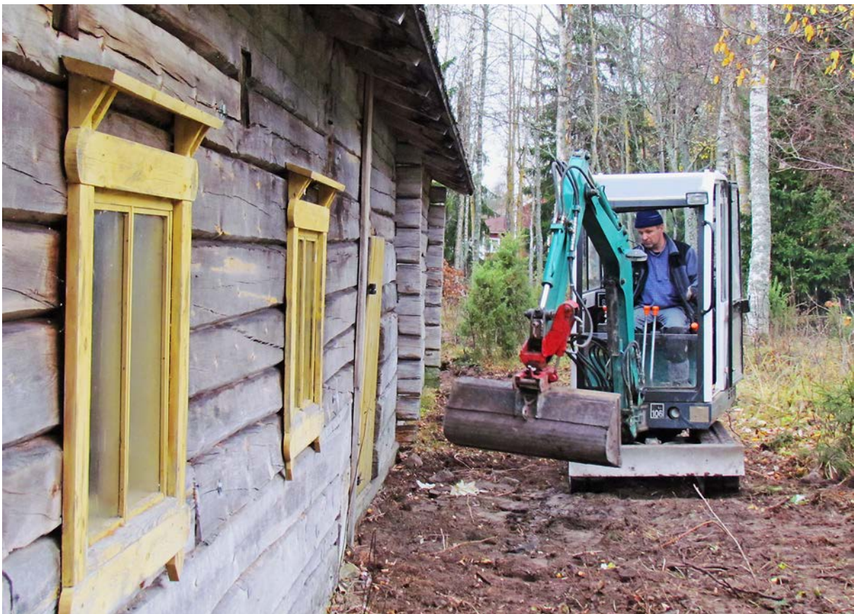
Restaurointimestari Marko Korkeasalo miehineen kunnosti Pahnilan museolla liiterin katon. Maanpinta muotoillaan pinta-vesien johtamiseksi pois rakennuksen seinustalta.
