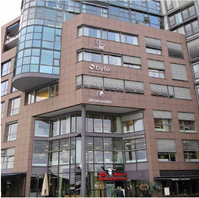
Kuva 4. Punaisesta graniitista (Carmen Red) valmistettu julkisivu Osllossa. Kuva: Olavi Selonen.
