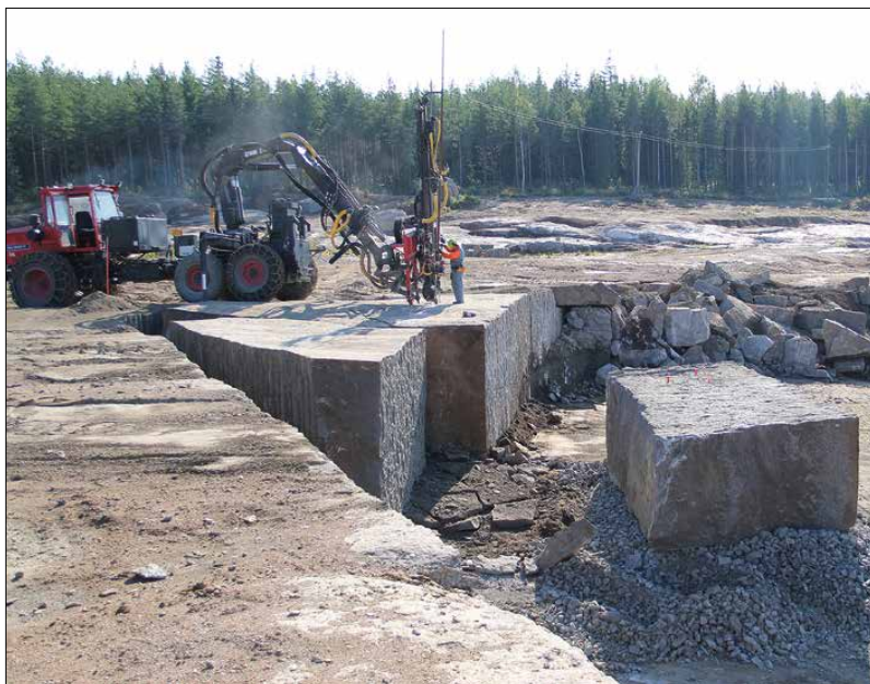
Kuva 5. Tyypillistä graniitinlouhintaa. Kami on irrotettu, paloitteluporaus on käynnissä ja kaatolohkare on kaadettu maahan. Kuva: Maria Palin.
