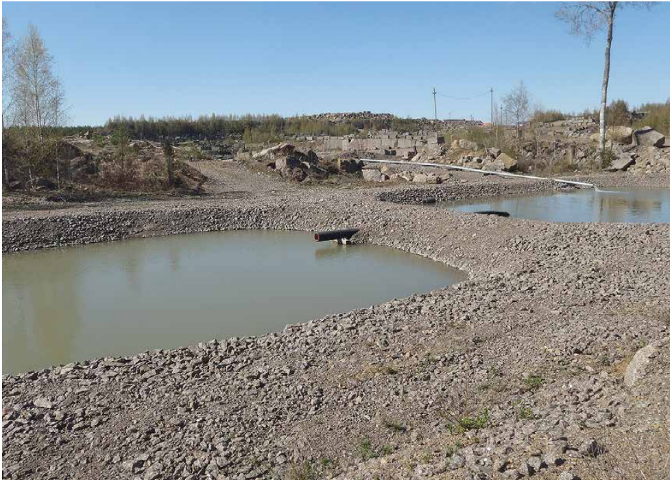
Kuva 43. Kaksiosainen selkeytysallas, jonka kautta kuivatusvedet johdetaan. Kuva: Sara Piutunen.
