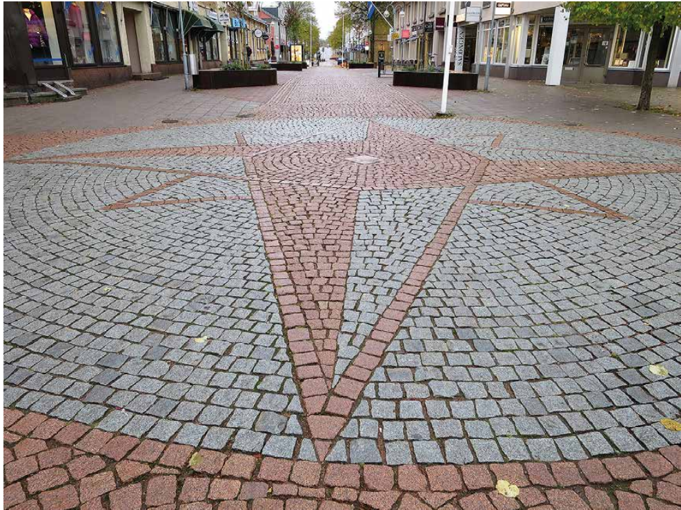
Kuva 1. Kadun päällystekiviä (noppakiviä) paikalleen asennettuna Maarianhaminassa. Kivet ovat laadultaan Kurun harmaata (Kuru Grey) ja Finströmin punaista (Archipelago Red). Kuva: Olavi Selonen.
