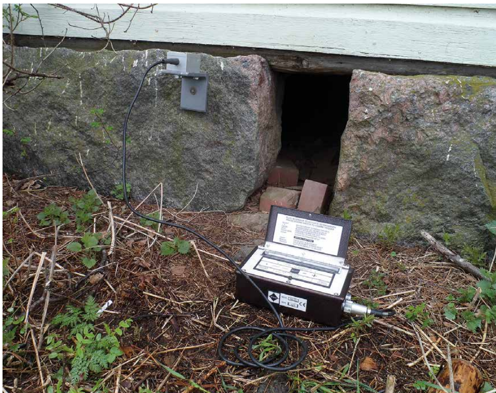
Kuva 36. Mittauslaitteisto asennettuna mittaamaan tärinää rakennuksen perustuksesta. Kuva: Jani Kankare
