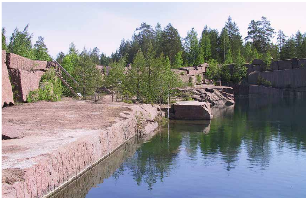
Kuva 47. Luonnonkivilouhimon maisemoinnin tärkein tavoite on saattaa alue turvalliseksi. Kivilohkareista tehty kivimuuri ympäröi maisemoitua louhimoa. Muuri on niin korkea, että sen ylitse pääsemiseksi tarvitaan portaat. Louhintarintaukset ovat pysyviä kiveä rikkomattoman louhintatekniikan ansiosta, eikä rintauksia tarvitse tukea. Vesiallasta käytetään tässä vanhassa louhimossa uimiseen ja sukeltamiseen. Kuva: Olavi Selonen.
