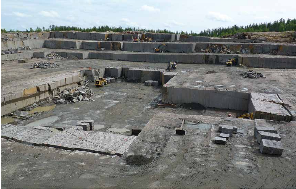
Kuva 11. Suuri graniittilouhimo, jossa porayksiköt ja työkonet ovat toiminnassa. Louhinta etenee penkereittäin. Varovaisesta räjäytystekniikasta johtuen louhimon pystyseinämat ovat pysyviä. Kuva: Jani Kankare.
