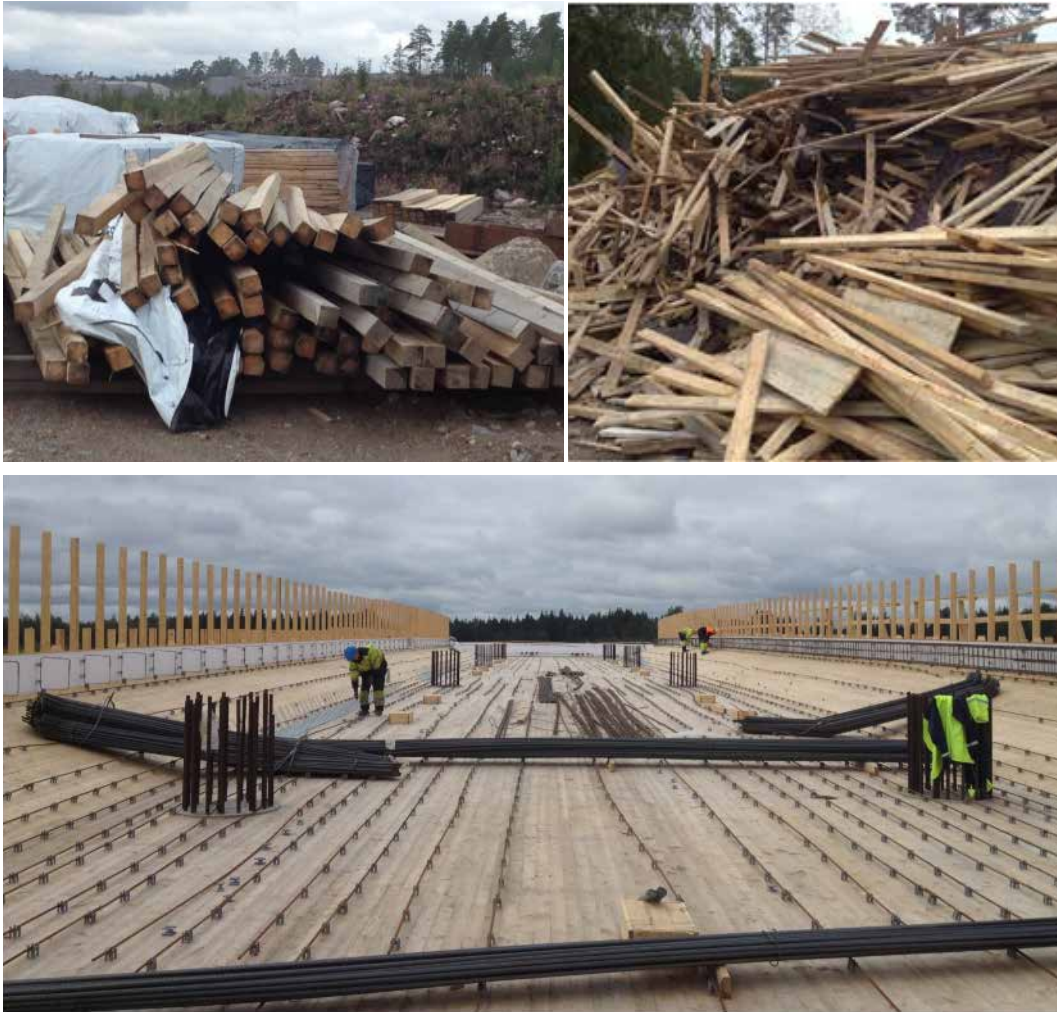
Kuva 5. Masku-Nousiaisen siltatyömaa sekä työmaan muottipuuta ja puujätettä. (Janne Hannula, L&T)
