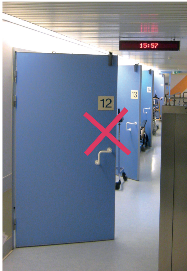
Kuvat 34 ja 35. Piirroksessa ja valokuvassa näkyy, miten käytävälle vastakkain avautuvat ovet estävät käytävällä esteettömän ja turvallisen liikkumisen.
