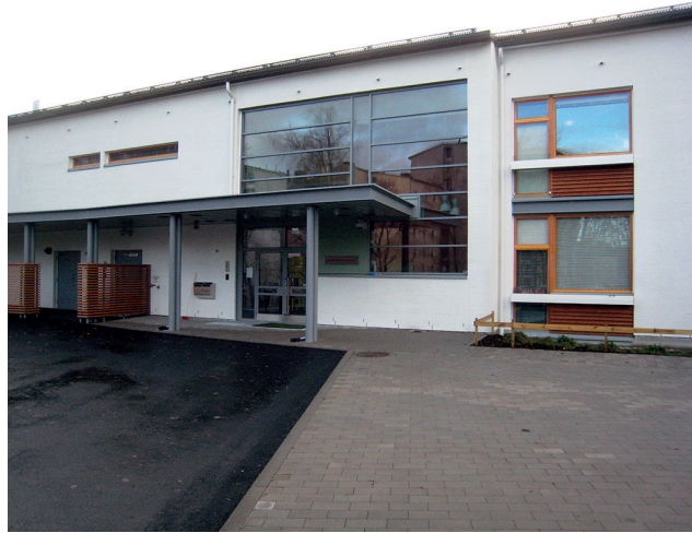
Kuvat 14 ja 15. Kohteessa on hyvin ratkaistu korkeuserot. Sisäänkäynti on tehty esteettömäksi maastonmuokkauksella.
