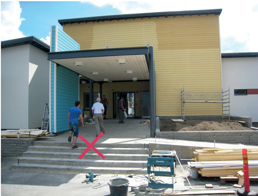
Kuva 17. Tässä on jopa vaarallinen esimerkki sisääntuloalueen porras- ja luiskaratkaisuista, jossa sisääntulo-ovelta lähtevä luiska johtaa suoraa portaille.
