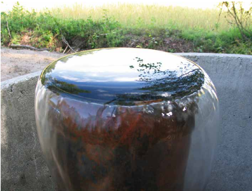
Kuva 19. Paineellinen pohjavesi voi hallitsemattomasti aiheuttaa ongelmia (Kuva: Jouni Lehtonen)
