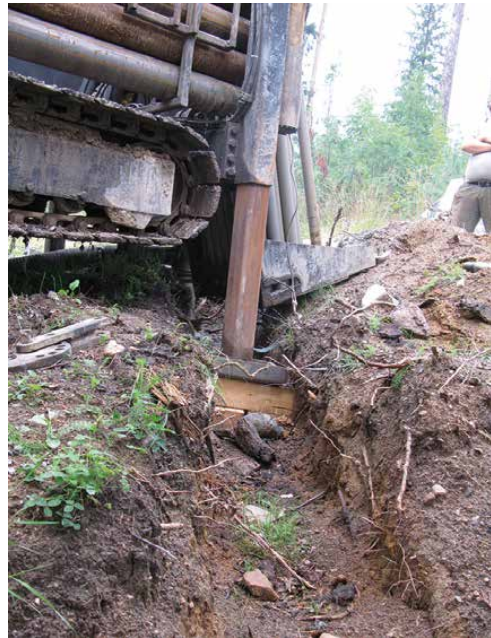
Kuva 12. Porauksen valmistelu on helpompaa, kun kaivutyöt tehdään porauksen jälkeen. (Kuvat: Janne Juvonen)
