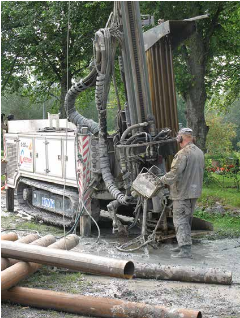
Kuva 12. Porauksen valmistelu on helpompaa, kun kaivutyöt tehdään porauksen jälkeen. (Kuvat: Janne Juvonen)
