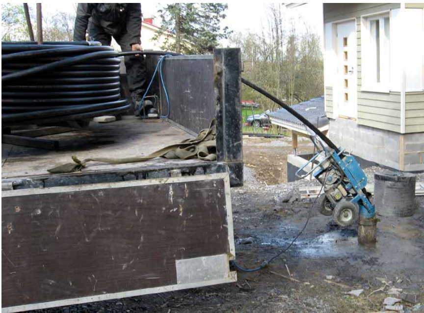
Kuva 15. Keruuputkien asennusta syöttölaitteella. (Kuva: Vesa Purakasmäki)
