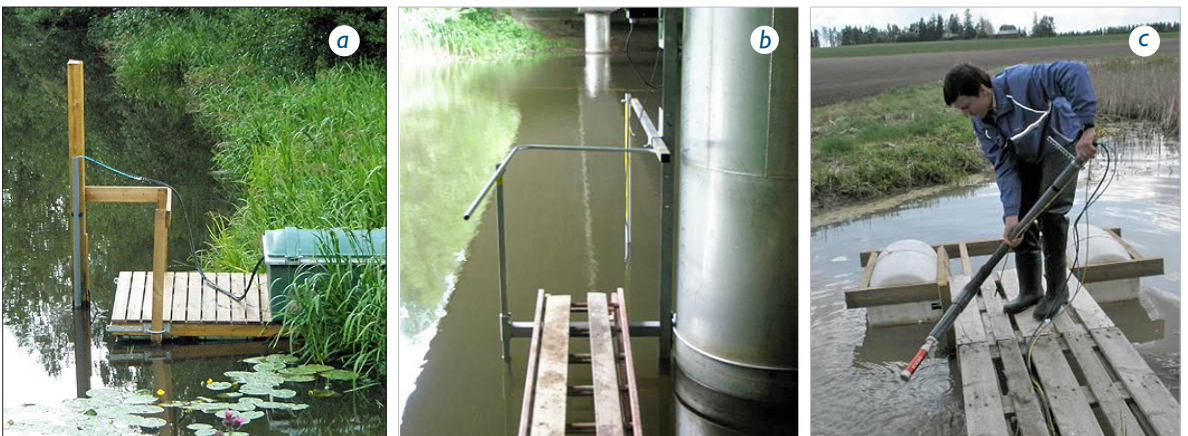
Kuva 7. Esimerkki a) laituri- ja b) siltakiinnityksestä. Telineen etuosa on tehty helpottamaan huoltotoimia. c) S::can-spektrometrin L-muotoinen asennusteline (Kuvat: Lippo Sundberg, MTT).
