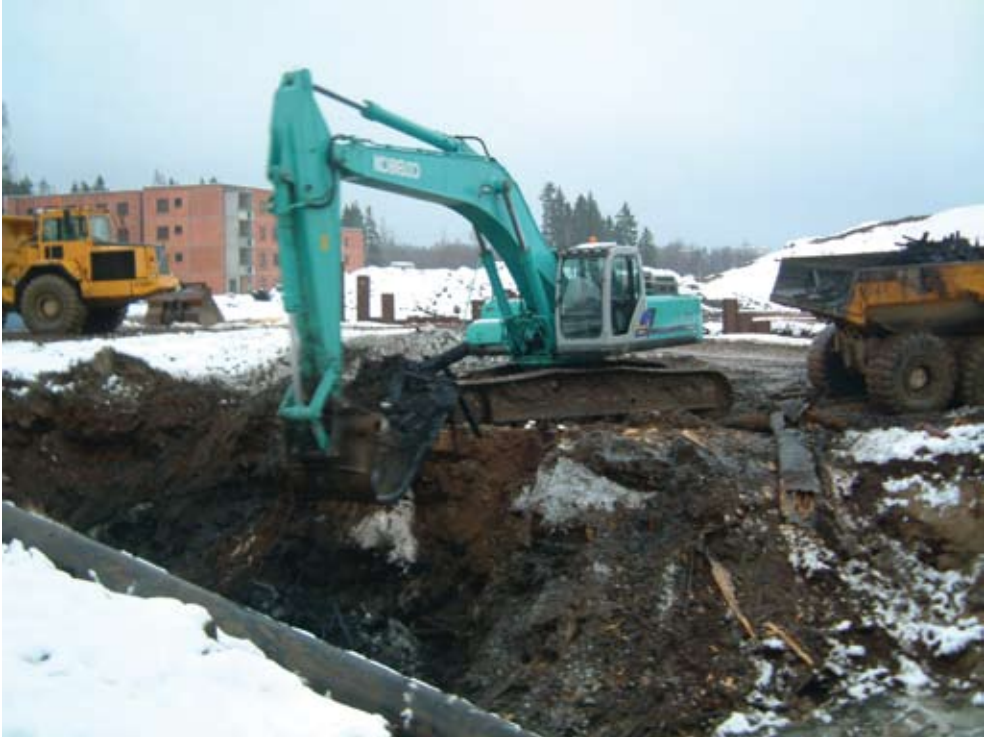
Kuva 10. Pilaantuneen maan kaivutyössä on sortumavaara. Kuva: Jorma Lappalainen
