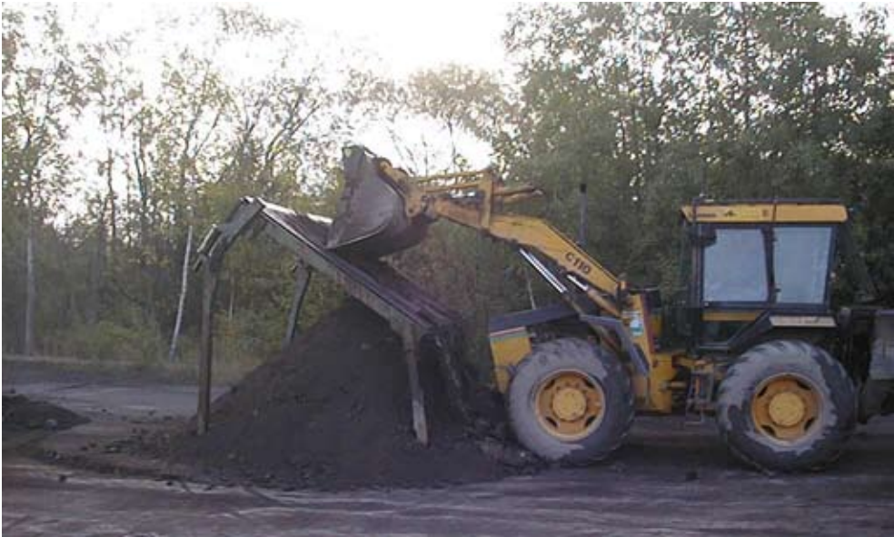
Kuva 9. Maa-aineksen seulonta (Marksanering 2002). Kuva: Skanska AB
