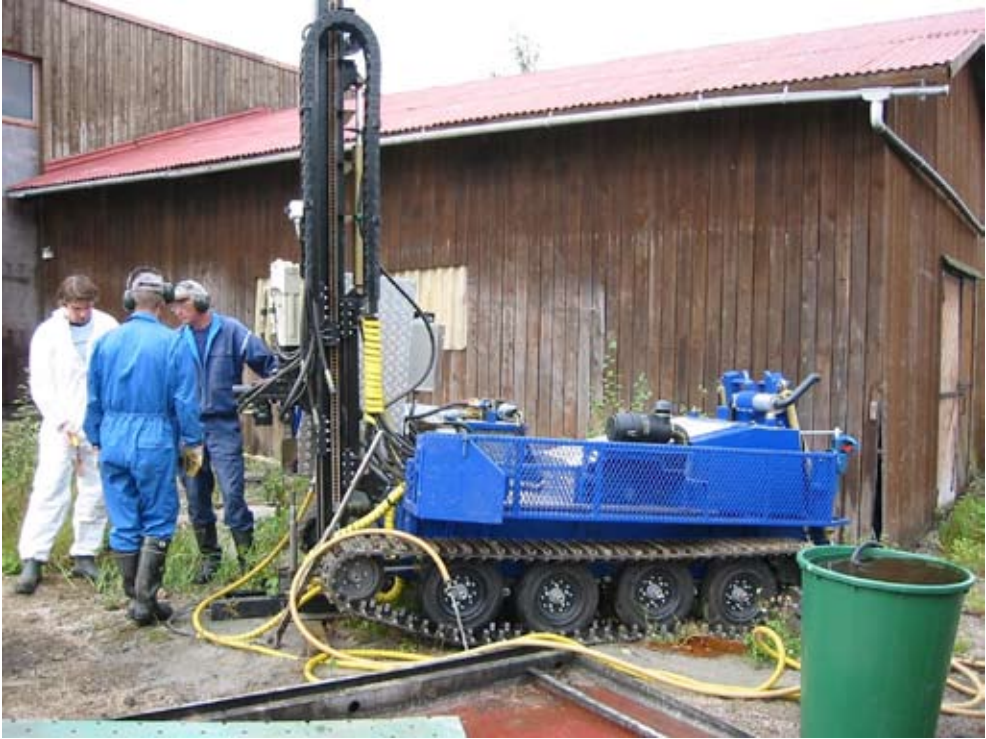
Kuva 4. Pohjavesiputkien asennusta, johon liittyy tapaturma-, melu- ja kemikaaliriskejä. Kuva: Länsi-Suomen ympäristökeskus
