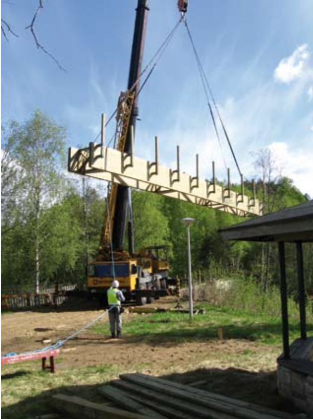
Kuva 7. Sillan reunapalkin asennustyö (Ari Räsänen, Pohjois-Savon ympäristökeskus)
