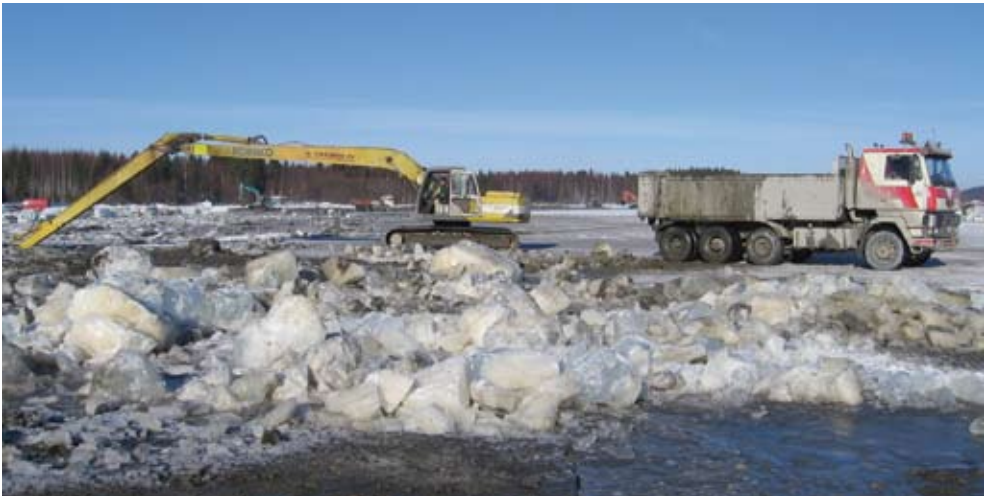
Kuva 8. Ruoppausta jään päältä (Ari Räsänen, Pohjois-Savon ympäristökeskus)
