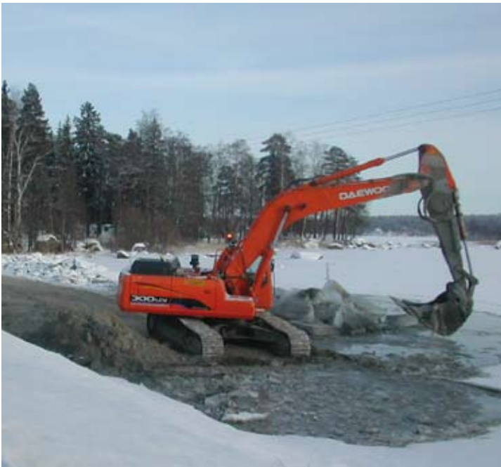
Kuva 9. Kaivutyö rannalta (Marko Rocklin, A-Rakennuttajat Oy)
