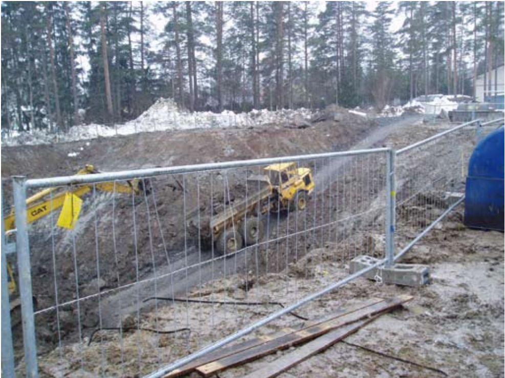
Kuva 4. Työmaakaivanto on eristetty suoja-aidalla (Tanja Seppälä, Pirkanmaan ympäristökeskus)
