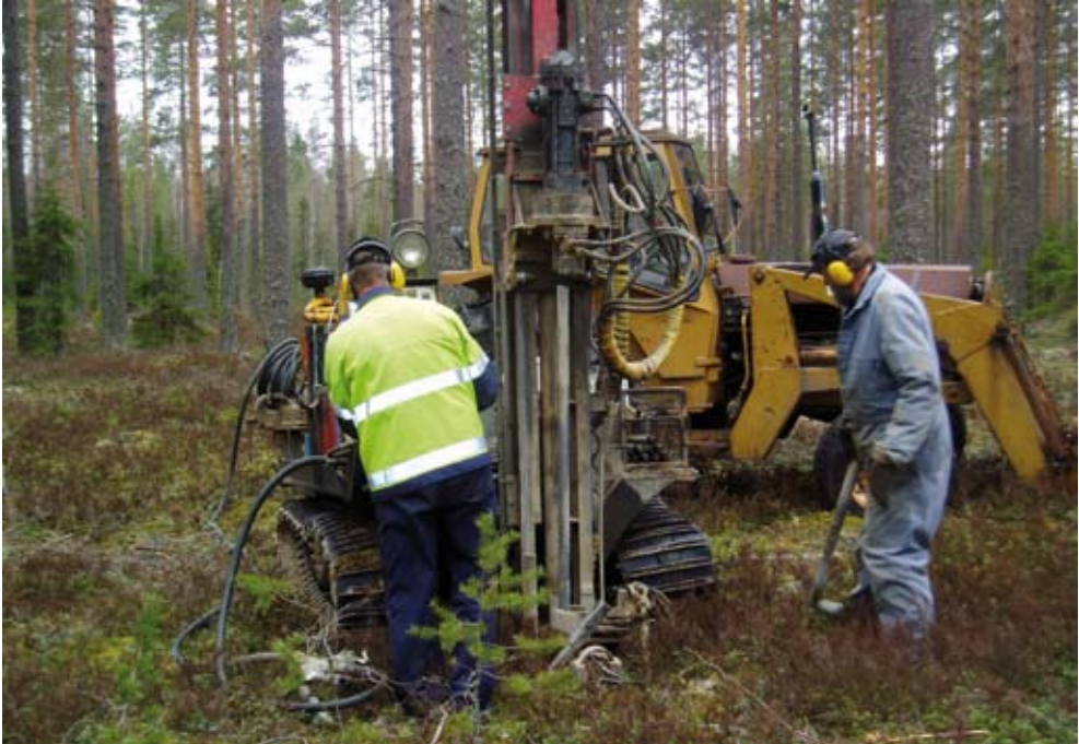
Kuva 1. Kuulosuojaimet ovat tarpeen pohjavesiputkien asennustöissä (Jouni Korhonen, Pirkanmaan ympäristökeskus)
