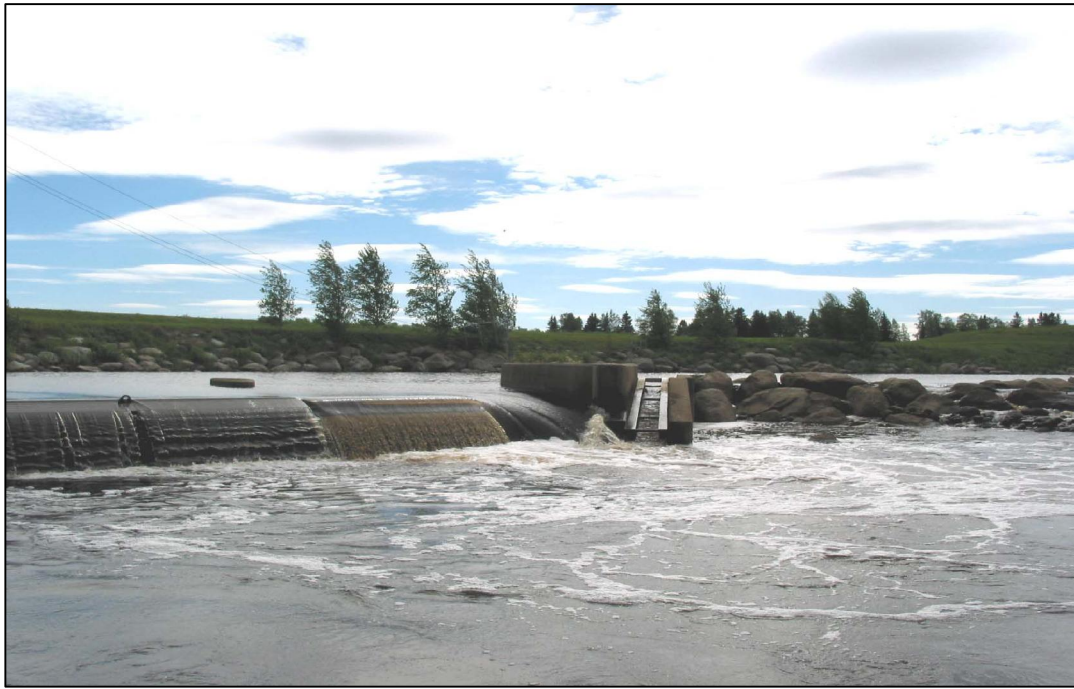
Kuva 12. Malkakosken pato kesällä 2006. Kalat oleskelivat säätöluukun ylivuotokohdan ja Denil-osuuden alaosan yhtymäkohdassa.
