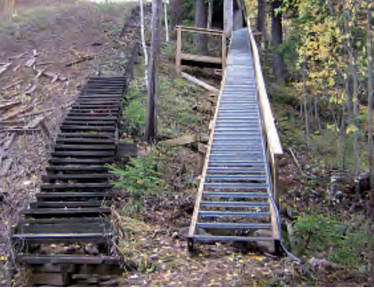
Suonenjoen hyppymäen portaat uusittiin. Kuvassa vierekkäin purettavat vanhat portaat ja rakennetut uudet portaat.
