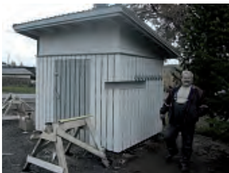
Alapihan kartanolla rakennettiin jätekatos.
