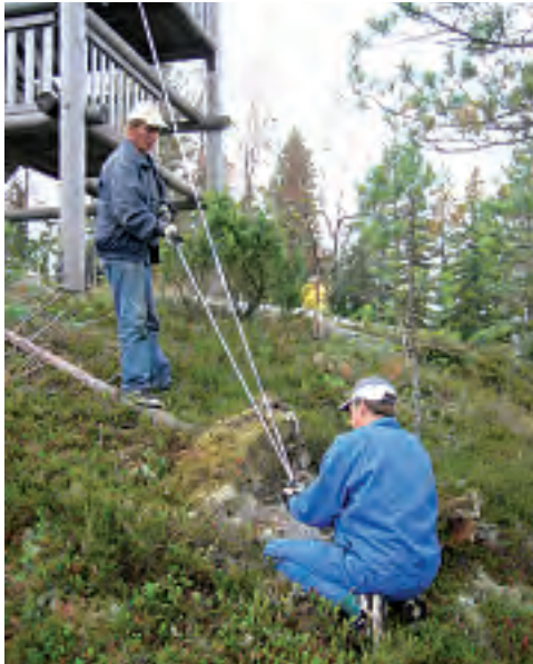
Kiparin näköalatornin huojumista estämään asennettiin haarukset, jotka porattiin kiinni kallioon.
