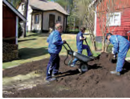
Yty-työntekijät korjaavat vesijohtotöistä tulleita vaurioita Talliniemessä
