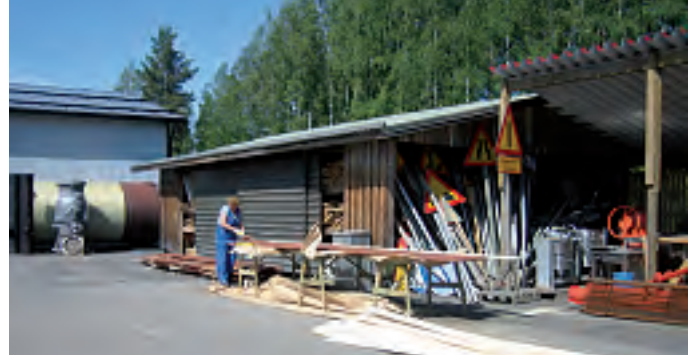
Aitoihin tulevat laudat maalattiin valmiiksi.
