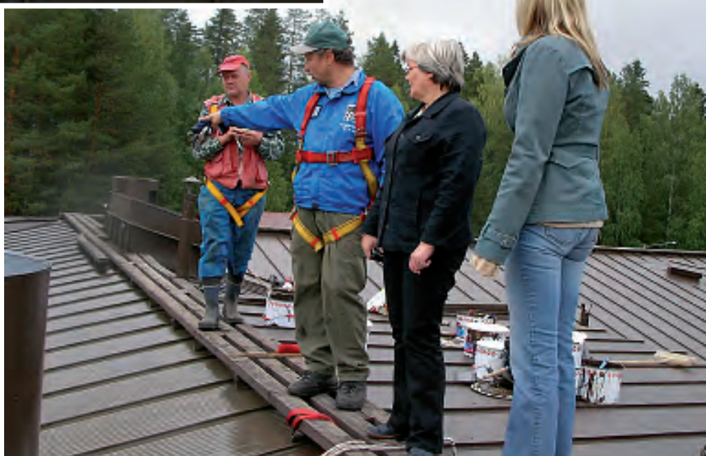
Tuusniemen viraston katon vanhat maalit poistettiin kemiallisesti ja katto maalattiin uudelleen. Korkealla katolla turvavälineet olivat ensiarvoisen tärkeitä. Projektipäällikkö Pirjo Karinen ja projektsihteeri Elina Väisänen tutustumassa maalaustöiden etenemiseen.
