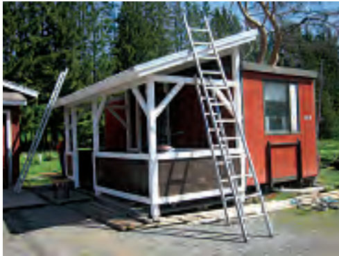
Yty-työmiehet rakensivat kaupungin taimiston taukokoppiin uuden sadekatoksen ja maalasivat sen.
