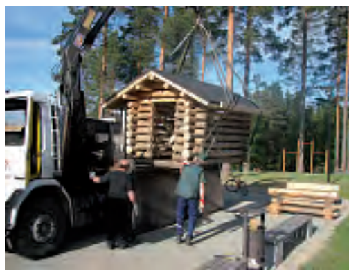
Koirakoskelle siirrettiin Sonkajärven kunnan varikolla tehty halkoliiteri. Liiteri tuettiin siirtoa varten laudoituksella.
