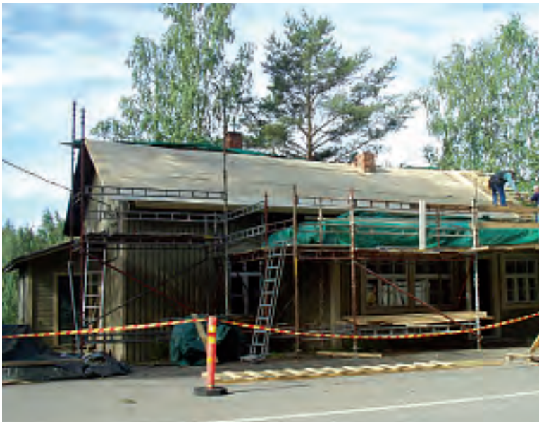
Vanha katto purettiin ja tilalle rakennettiin uudet kattoruoteet.
