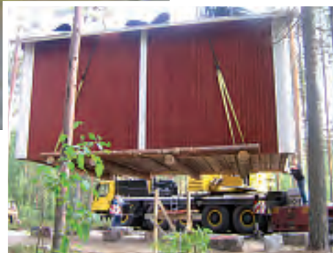
Museoaitta siirrettiin suunnitellulle paikalle ortodoksisen kirkon viereen. Siirto tapahtui nostamalla koko rakennus lavetille ja ajamalla rakennus paikalleen. Kuvat Pekka Uusisuo.
