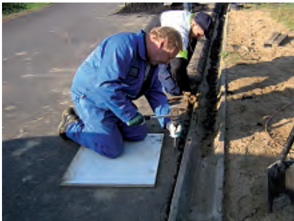
Hoitokoti Pauliinan pihalle asennetaan betonikourua.
