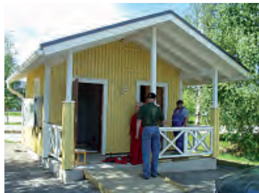
Lohitien wc-rakennuksen sisätyöt tehtiin valmiiksi ja se maalattiin. Työsuunnittelija Pertti Huttunen ja projektipäällikkö Pirjo Karinen käyvät työntekijän kanssa läpi tehtyjä töitä.
