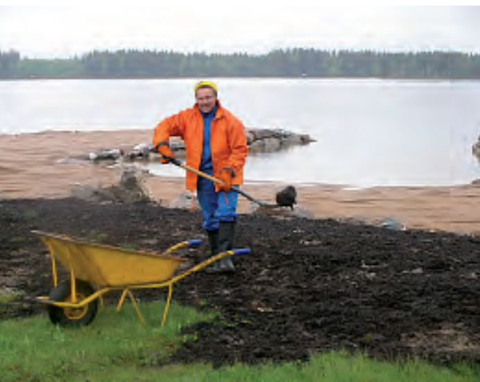
Yty-työmies levittelee multaa nurmikkoa varten.
