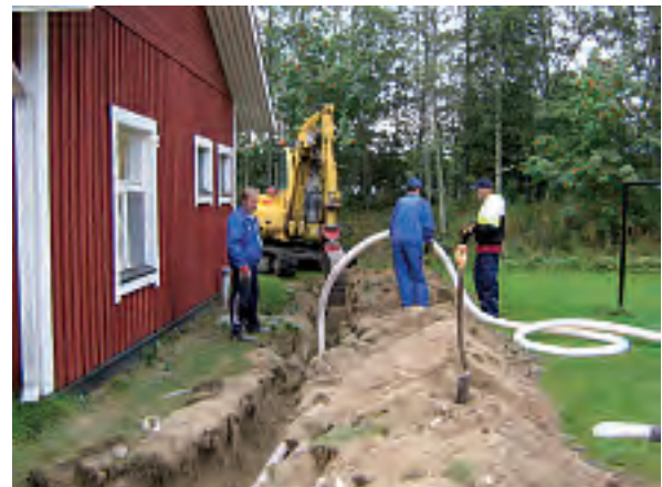
Kerkonkosken vuokrataloille valmistuu uusi salaojitus.
