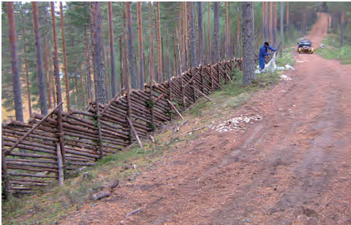
Lintharjun hiihtoreitille tehtiin pisteaitaa lumiesteeksi.
