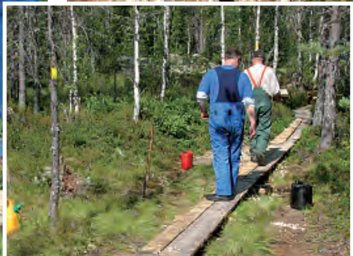
Volokin polulle laitettiin pitkospuita. Yty-miehet porasivat reiät tapeille ja hakkasivat tapit paikoilleen puuvasaralla.
