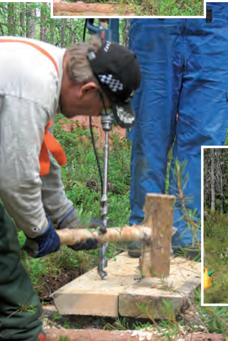
Volokin polulle laitettiin pitkospuita. Yty-miehet porasivat reiät tapeille ja hakkasivat tapit paikoilleen puuvasaralla.
