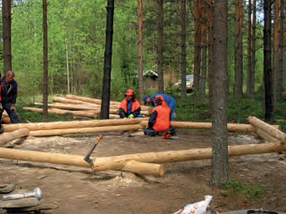
Hanhilammen kodan rakentajat tarkastamassa hirren varausta.
