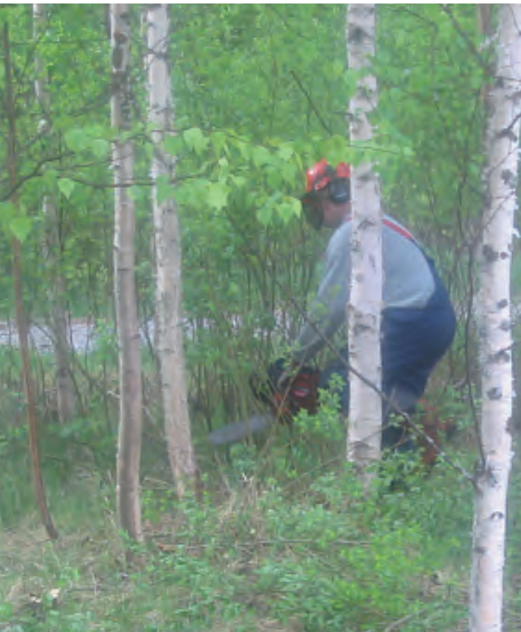
Raivaustöitä tehtiin eri puolella Nilsää. Kuvassa yty-mies raivaamassa näkymäaluetta rantaan.
