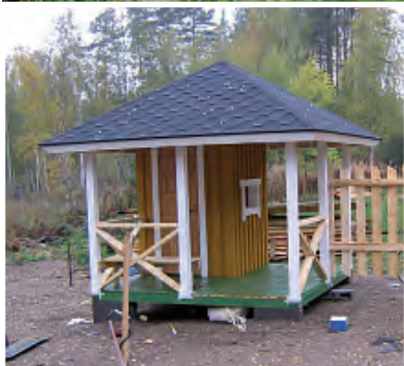
Vesannon Asinsalmen tanssilavan kunnostus tehtiin suunnitelmien mukaan. Katto tuettiin ja oikaistiin. Lavan ulkovuoraus uusittiin ja maalattiin keltamultamaalilla. Uusi lippukoju rakennettiin vanhan tilalle.
