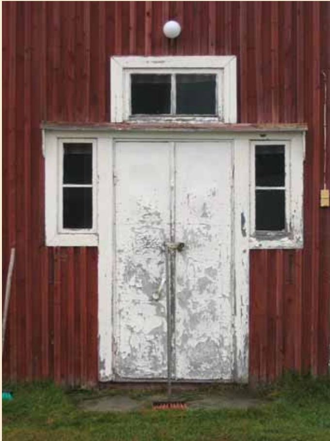
Kuivalan vanhan puolen ovi ikkunoineen. Syksyllä 2006.
