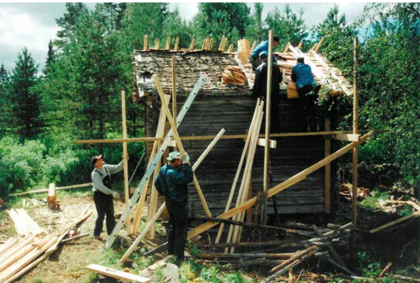
Tikkalan aitan tuohikaton kunnostusta kesällä 1999.
