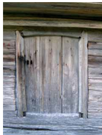
Jonkerin Matovaaran karjalaisvaikutteinen navetta. Oikealla: Lentuan Saaren aitta on vuodelta 1683. Ovi on äärimmäisen yksinkertainen: kolme lautaa pienoilla kiinni toisissaan ja kaksi kiilattua pihthielipuuta karoina. Kesä 2005.
