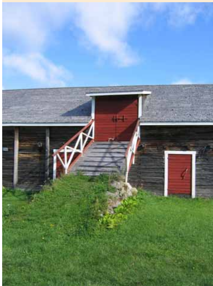
Pöyhölän navetan silta. Kesällä 2005.
