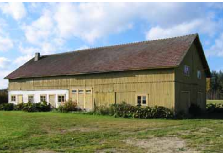
Tyrävaaran tyylipuhdas 50-luvun navetta. Kesällä 2005.
