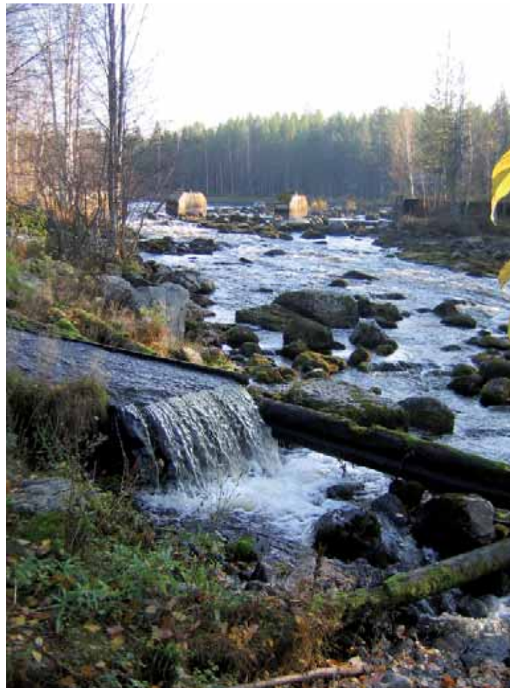
Kaarneenkosken ränni- ja patolaitteita. Syksy 2005.
