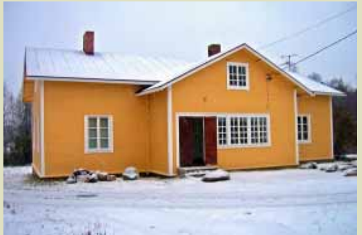
Kemilän kunnostettu asuinrakennus.
