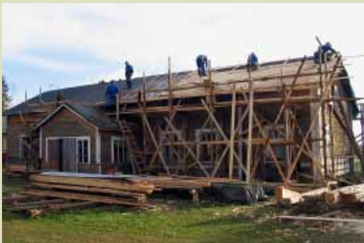
KUMARA-hanke kunnostamassa Immolan vanhaa päärakennusta. Kuva: Juhani Tolonen.
