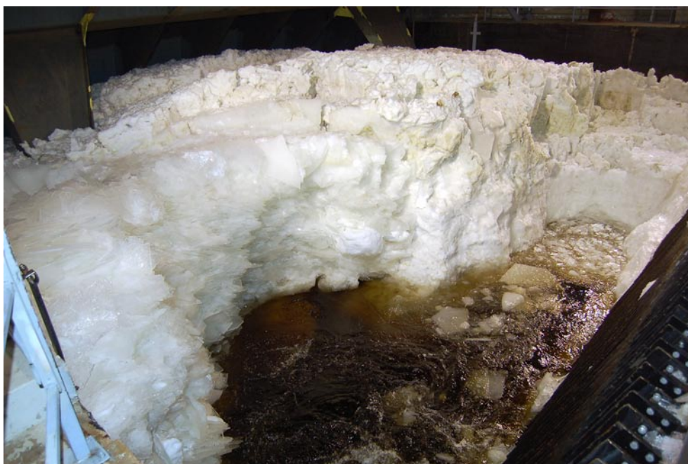
Kuva 13. Kasautunutta suppojäätä Merikosken voimalaitoksessa. (Kuva: Ahti Sipola, Oulun Energia, 29.11.2008)
