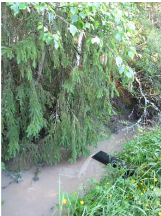
Kuva 14. Salaojien purkuputkien korkeudet tulee huomioida kosteikkoa suunnitellessa, ettei lähipelloille aiheudu kuivatushaittaa.
