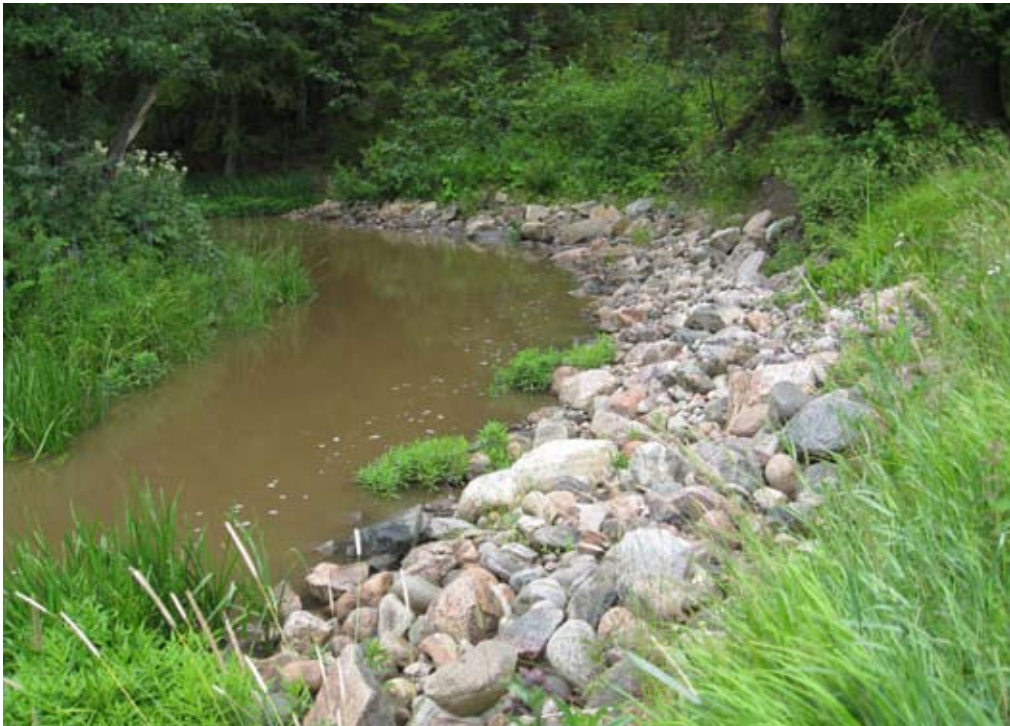
Kuva 11. Luonnonmukaisen rakennustavan mukaan tehty eroosiokorjaus Köylinjoelta. Kuva: Hanna Eskola.
