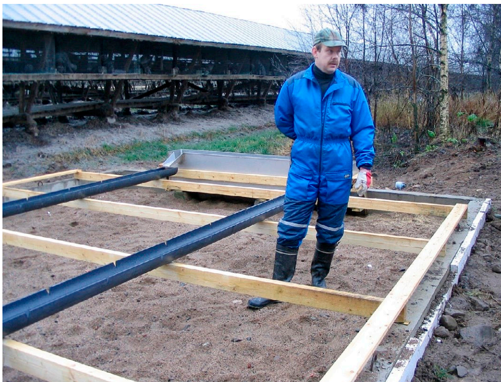
Bild 8. Sandfilter under uppbyggnad (Anne Polso/NTM-centralen i Södra Österbotten).
