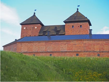
Kuva 57. Tunnistettavat näkymät ohjaavat kulkua ja luovat turvallisuuden tunnetta.
