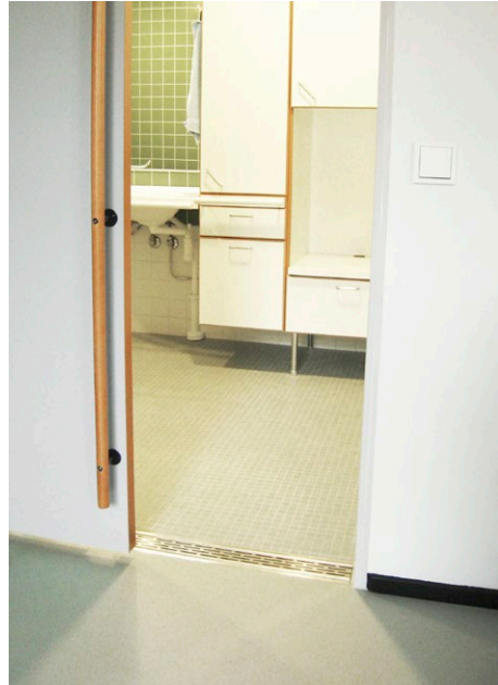
Kuva 144. Liukuovi säästää tilaa ja kynnyksikaivo estää veden pääsyn muualle.
