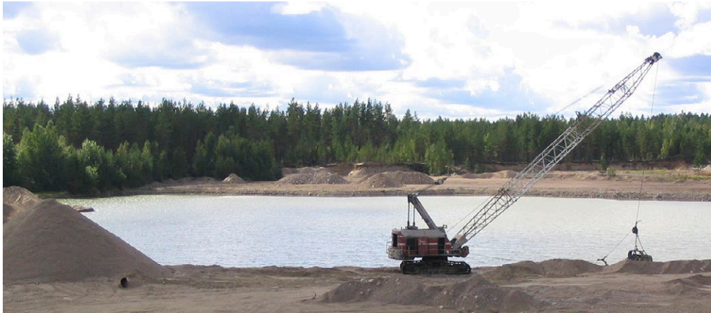
Kuva 21. Pohjavesialueen maa-ainestenottotilanne esitetään suojelusuunnitelmassa. Kuva: Jari Rintala.
