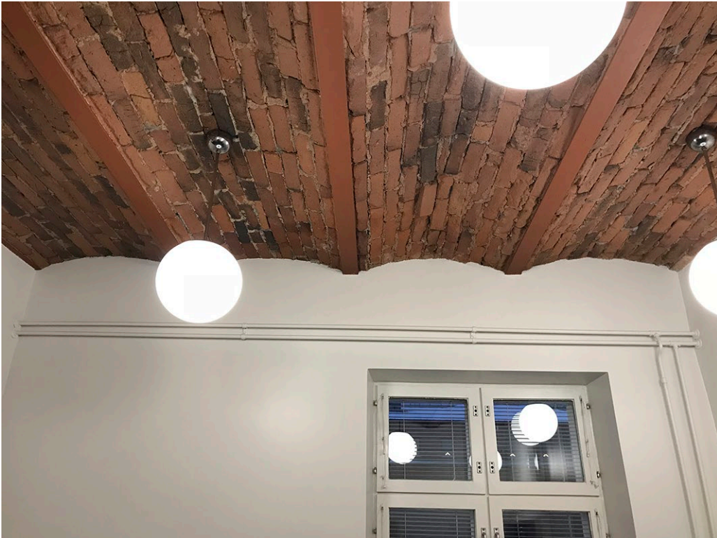
Kuva 33. Sisätilojen kappatiiliholvirakenteita (kuva Kari Nöjd).
