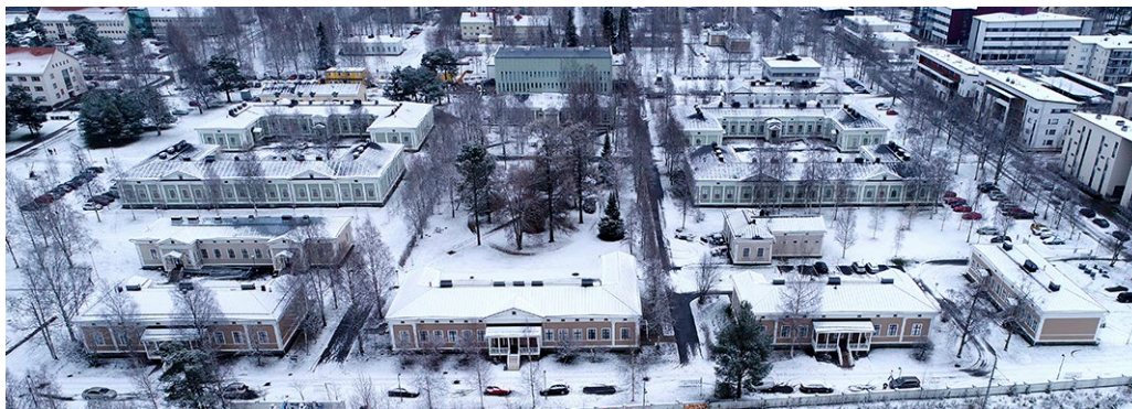
Kuva 34. Oulun puukasarmialue. Etualalla olevat kolme rakennusta on peruskorjattu asuinkäyttöön (kuva Kari Nöjd).
