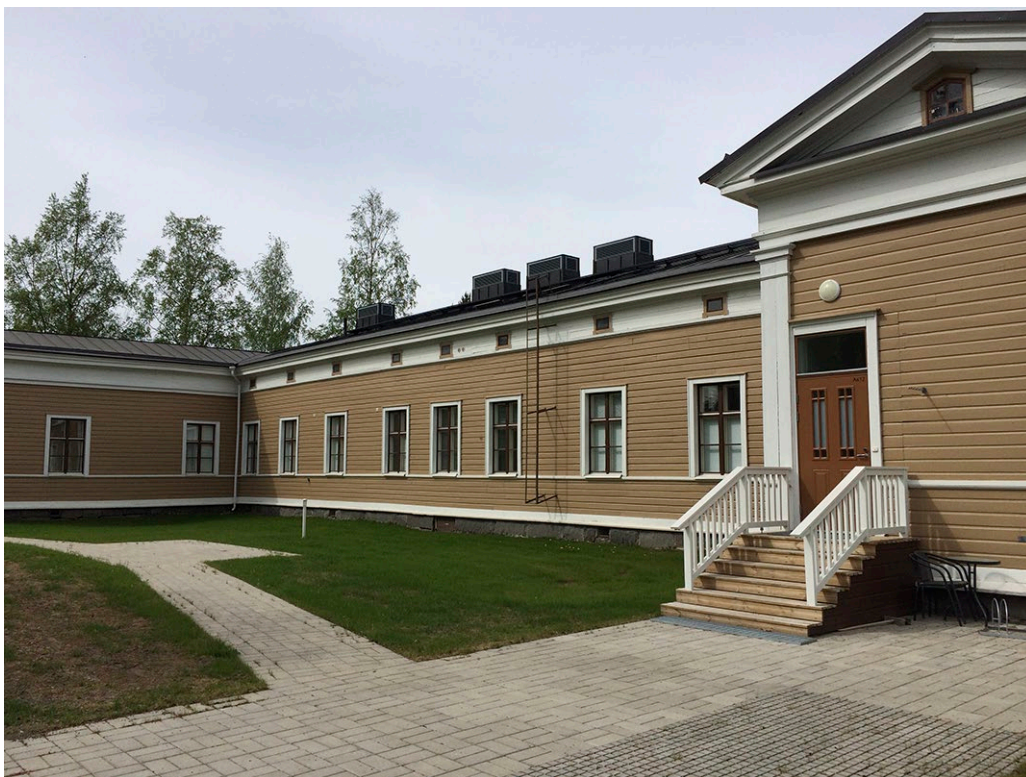
Kuva 36. Rakennusten ulkoseinät maalattiin ja ilmanvaihdolle otettiin käyttöön vanhat piippujen paikat (kuva Pekka Lehtinen).
