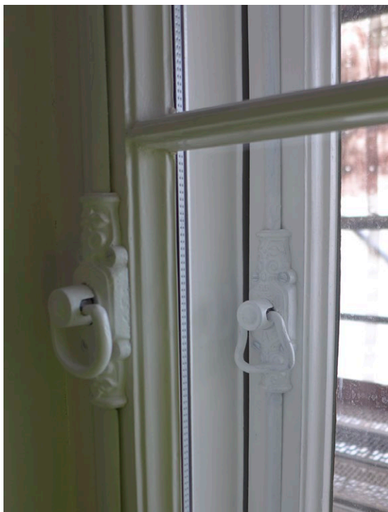
Kuva 20. Ikkunat kunnostettiin. Kuvassa yksityiskohtia kunnostetusta ikkunasta. (kuva Pekka Lehtinen).
