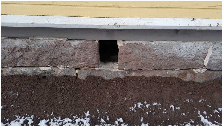
Kuva 14. Luonnonkivistä koottua ja laastilla muurattua perustaa (kuva Jyri Nieminen).
