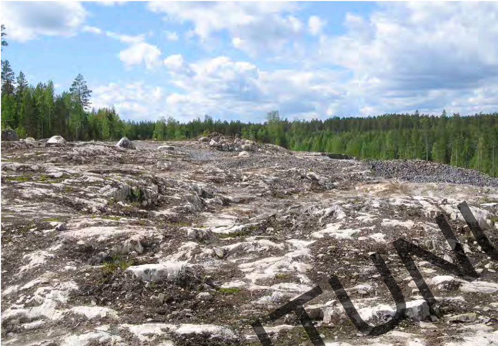
Kuva 26. Ennen varsinaista ottamistoimintaa alueelta poistetaan mahdollinen puusto sekä kuoritaan pintamaa, joka varastoidaan ottamisalueen reunalle.
