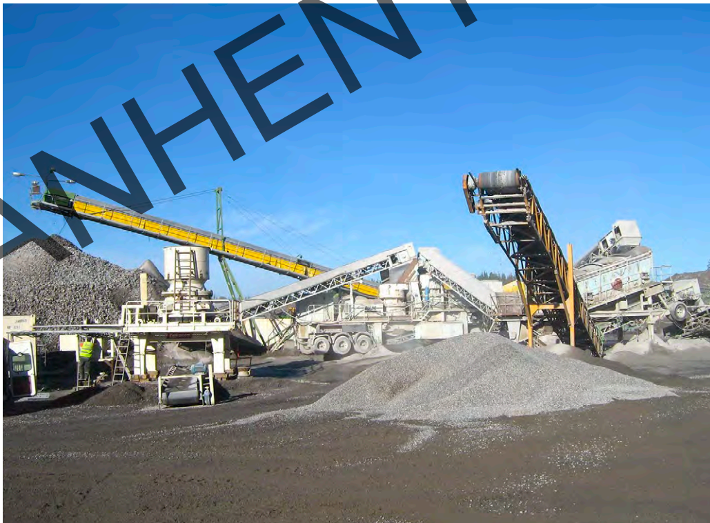
Kuva 10. Kivenmurskaamo edellyttää useissa tapauksissa ympäristöluvan.
