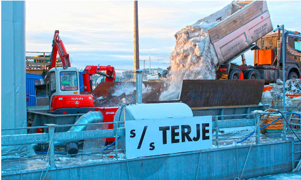
Kuva 9. NCC lumensulatuslautta Oslossa. Kuva: NCC AB.
