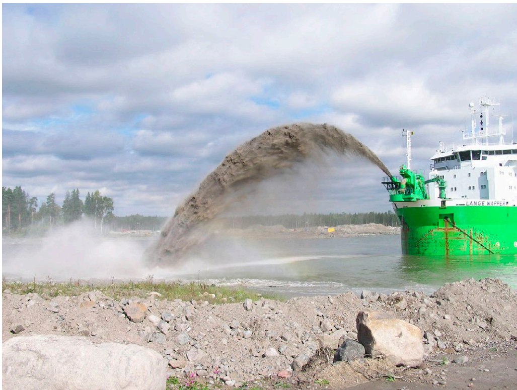
Kuva 9. Merenpohjalta nostettua merihiekkaa käytettiin Vuosaaren sataman (Niinilahti) pohjan täyttöihin. Merihiekka kuljetettiin belgialaisella Lange Wapper -hiekkahopperilla. Helsingin satama 2004/Paavo Lyytinen
