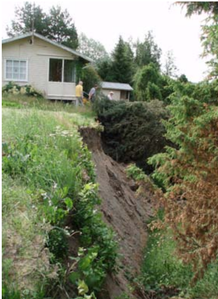
Ranta-örmän murtuma keväällä 2006. Kuva: Kimmo Pakarinen
