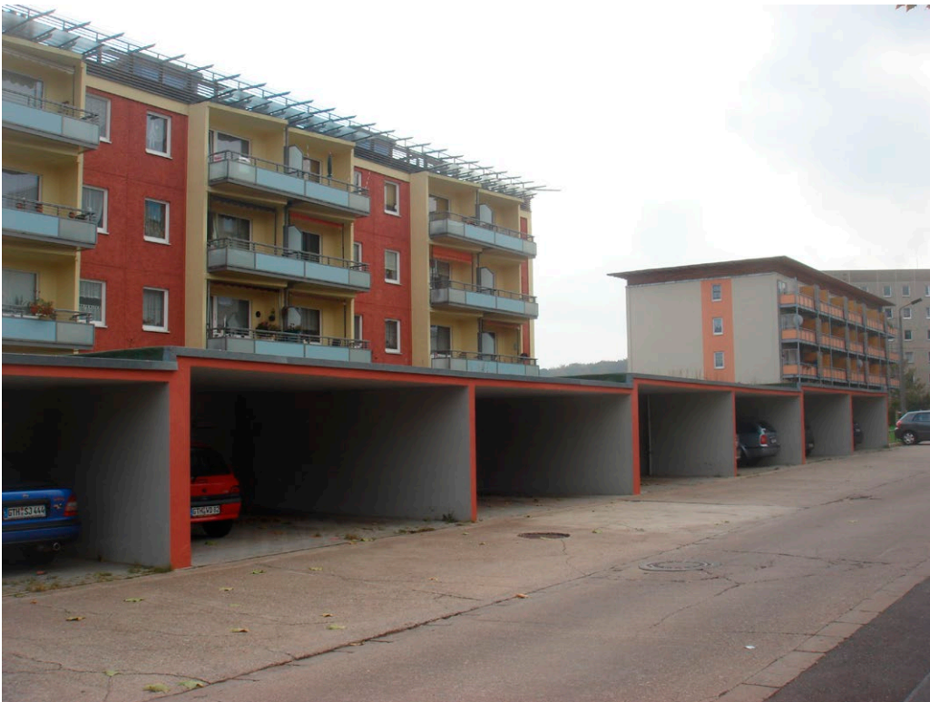
Kuva 8. Parkkialueen kohdalta puretun asuinrakennuksen betonielementeistä rakennettu autokatos, Gotha, Saksa, 2007. Taustalla näkyvät asuinkerrostalot on peruskorjattu. Kuva Jukka Lahdensivu.
