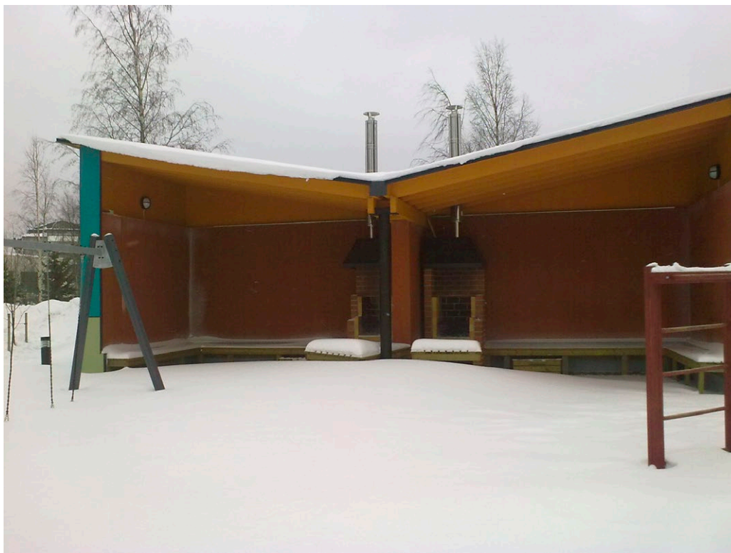
Kuva 10. Puretuista seinäelementeistä tehty grillikatos, Raahе. Kuva Jukka Lahdensivu.
