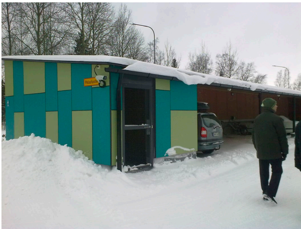
Kuva 11. Puretuista seinäelementeistä tehty autokatos, Raahe. Kuva Jukka Lahdensivu.
