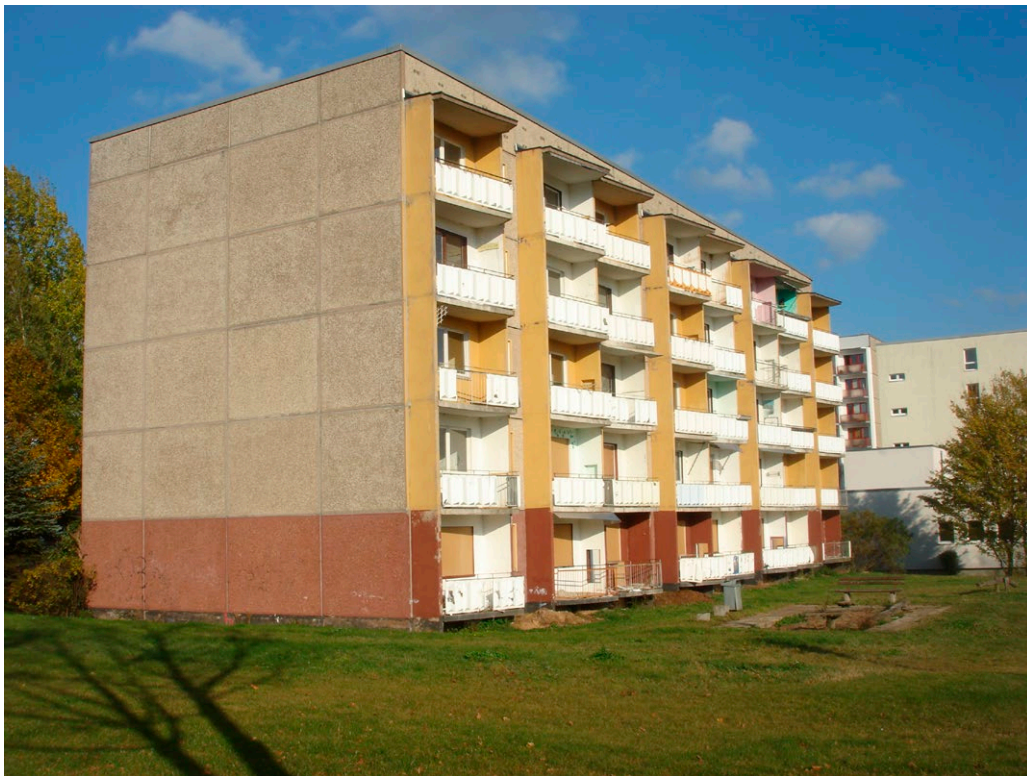
Kuva 6. Tyyppillinen DDR:n betonielementtijärjestelmän mukainen asuin-kerrostalo. Kuva Jukka Lahdensivu.
