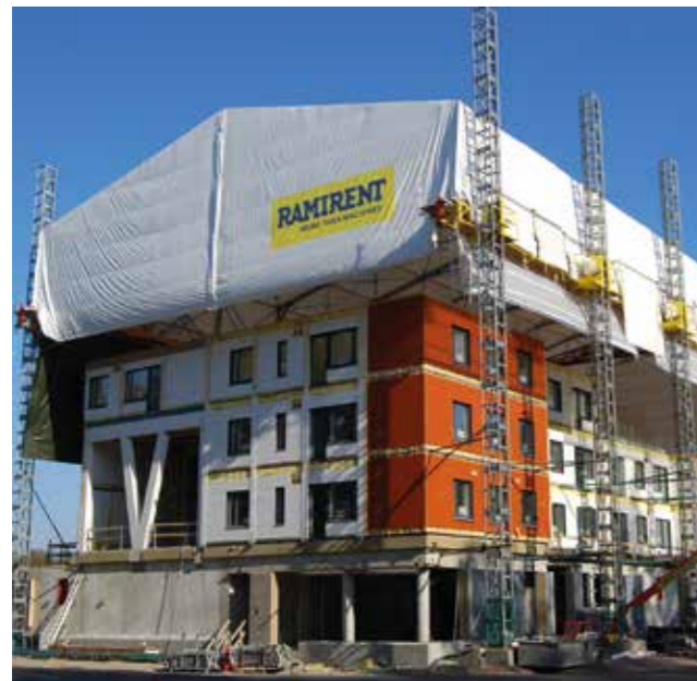
Kuva 6. Vantaan Ylästön Asuntomessuille 2015 valmistuva puukerrostalo työmaavaiheessa. (Kuva: Rakennusliike Reponen)
