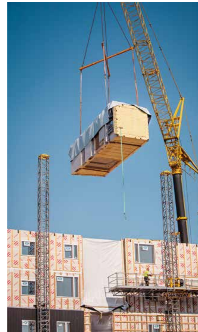
Kuva 8. CLT-tilaelementtejä pystytysvaiheessa. (Kuva: Puuinfo Oy)
