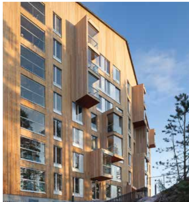
Kuva 7. Puukuokka 1, vuonna 2014 Jyväskylään valmistunut 8-kerroksinen puukerrostalo. (Kuva: Lakea Oy)
