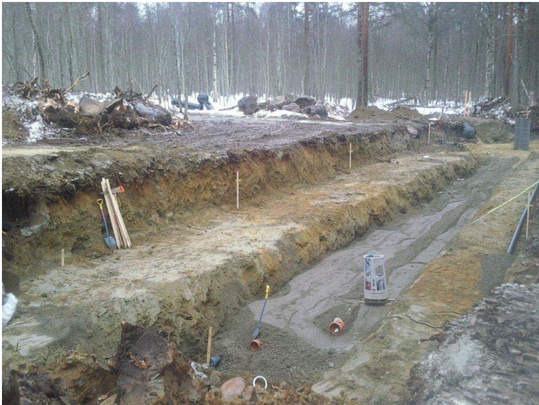
Joint construction in Karhunmäki area (Photo: Harri Pyöriäinen P-K:n KTK Oy)
