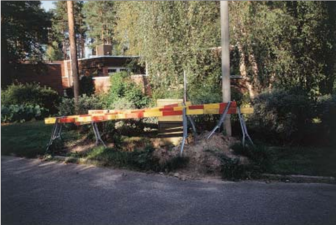
Kuva 35. Keinot "unohdetun" työmaan valmistumiseksi saadaan käyttöön, Oulu 2001.
