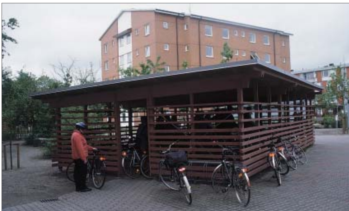
Kuva 27. Hyväntuokoinen katos. Pyörät ovat suojassa nimikkopaikoillaan ja helposti liikenteeseen otettavissa, Lund 2002.
