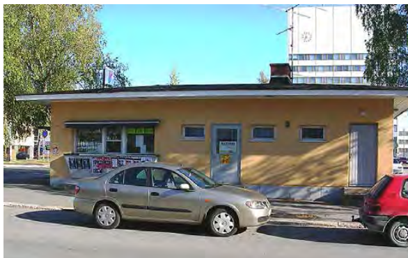
Kuva 70. Kemin entinen keskuskioski ennen mittavaa julkisivu-uudistusta. LKYT 2006.
