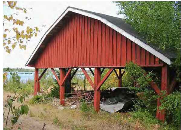
Kuva 103. Venekatos on vuonna 1925 valmistunut kookas venekatos, johon uiton veneitä laitettiin talvisäilöön. LKYT 2006.
