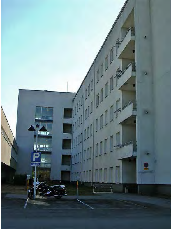
Kuva 56. Länsi-Pohjan sairaalan sisäpihaa. LKYT 2006.
