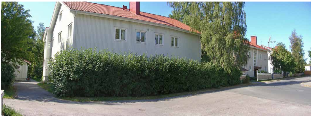
Kuva 40. Urheilukadun puutalokokonaisuutta. LKYT 2006.
