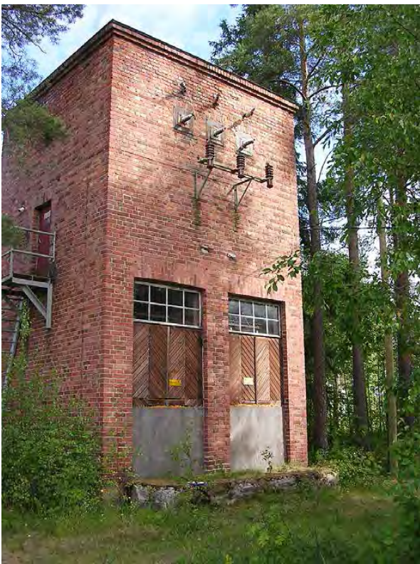
Kuva 106. Tiilestä rakennettu tornimainen muuntajaraken- nus vuodelta 1926. Uittoyhdistys osti rakennuksen 1957 Kemi Oy:ltä. LKYT 2006.
