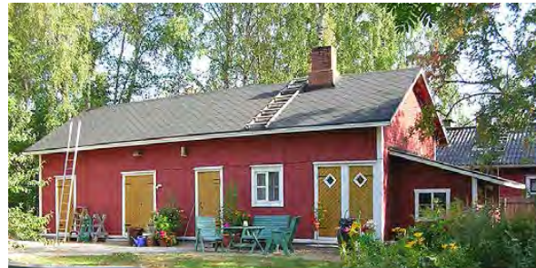
Kuva 43. Kaivokatu 22 ulkorakennus. LKYT 2006.
