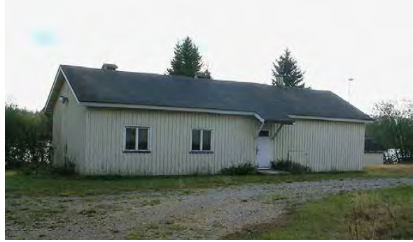
Kuva 132. Vallitunsaaren pesularakennus. LKYT 2006.
