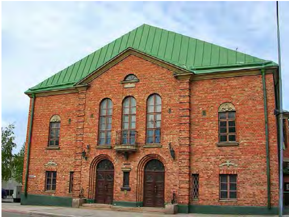
Kuva 37. Kemian pirtin päätyjulkisivu. LKYT 2006.
