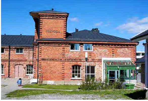
Kuva 35. Leipätehtaan sisäänkäynti. LKYT 2006.
