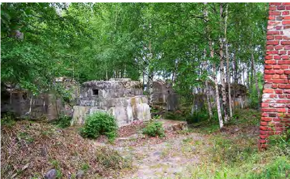
Kuva 89. Entisen saha-alueen rakenteiden jäänteitä. LKYT 2006.
