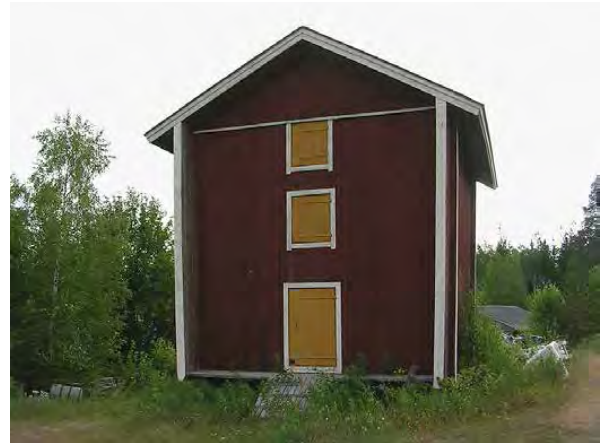
Kuva 110. Sotisaaren kolmikerroksinen aitta. LKYT 2006.
