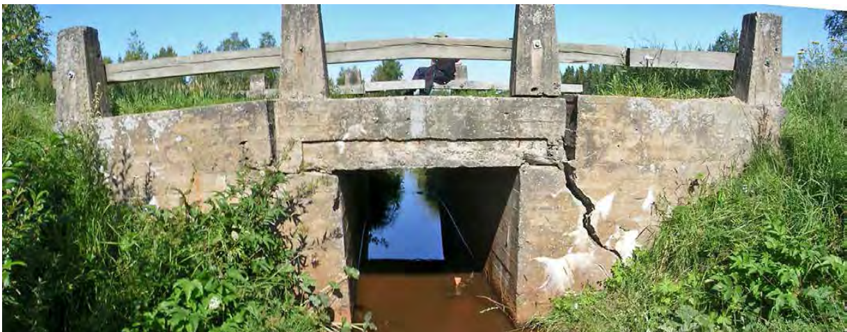
Kuva 150. Vanha maantiesilta. LKYT 2007.
