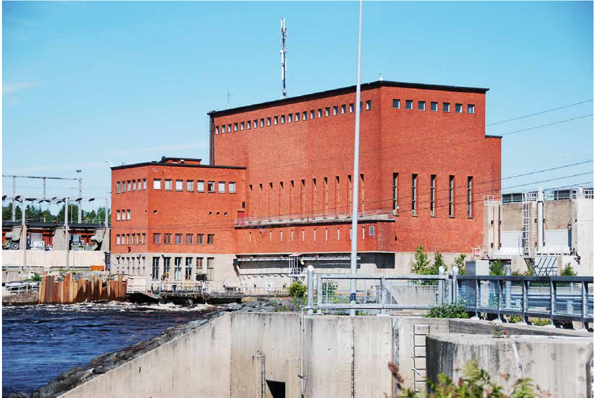
Kuva 1. Isohaaran voimalaitos on arvotettu valtakunnallisesti merkittäväksi rakennetuksi kulttuuriympäristöksi (RKY -kohde). Isohaara on ensimmäinen Kemijokeen rakennetuista voimalaitoksista, se valmistui vuonna 1949 ja sen on suunnitellut arkkitehti Sigurd Frosterus. Tiina Elo 2011.
