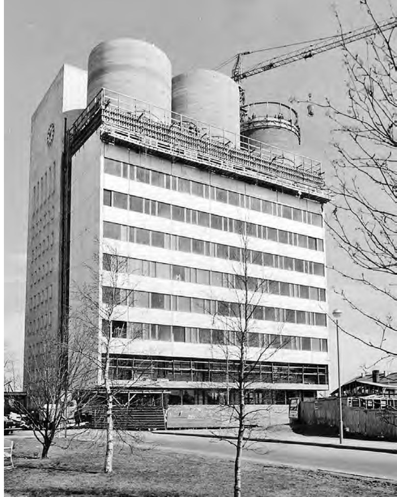
Kuva 57. Kemin kaupungintaloa laajennetaan vuonna 1966. Kerroksien 10–12 välisellä alueella sijoitettiin vesisäiliöt, joiden yhteenlaskettu tilavuus on 2 500 kuutiota. Kemin historiallisen museon valokuva-arkisto.
