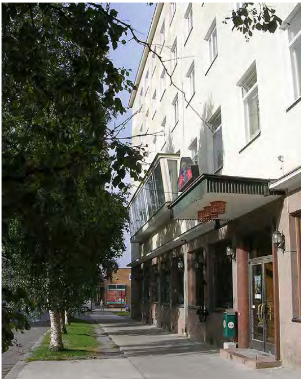
Kuva 67. Ravintolan sisääntulon puoleista julkisivua. LKYT 2007.
