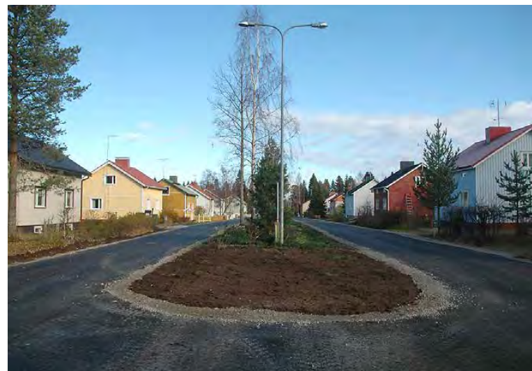
Kuva 21. Lastaajankatu Ajoksessa. Minna Heljala 2013.
